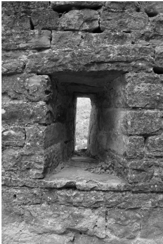
Slika 65., Petrapilosa, strjelnica sjevernog zida unutrašnjeg dvorišta
