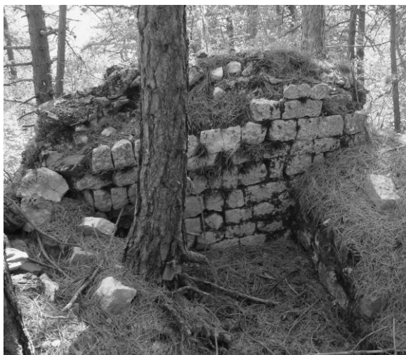
Slika 123., Rašpor, fragment južnog zida
