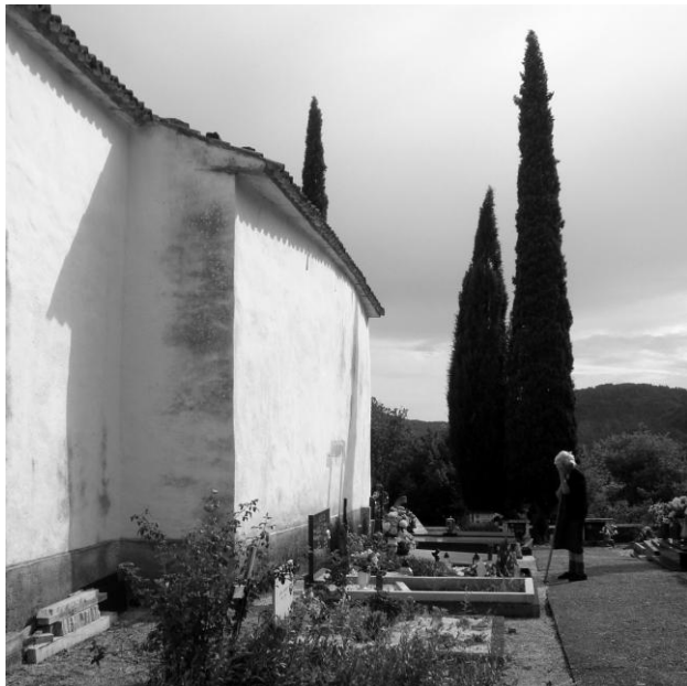
Slika 52., Črnica, crkva sv. Lovre sa sjeverozapada
