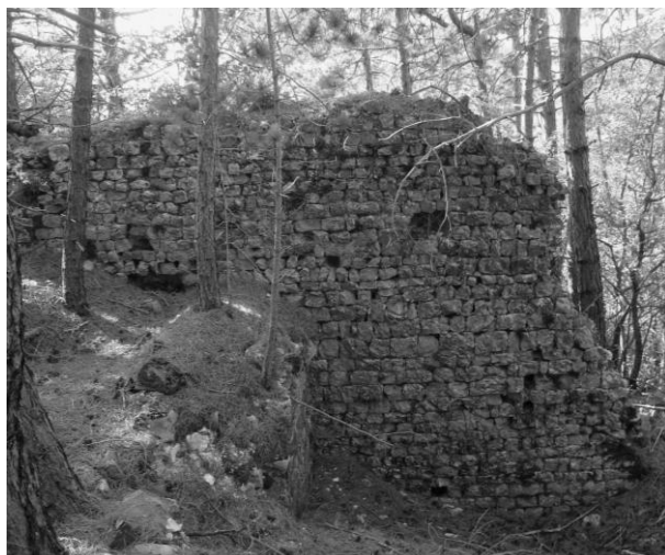
Slika 122., Rašpor, zapadni zid s unutrašnje strane
