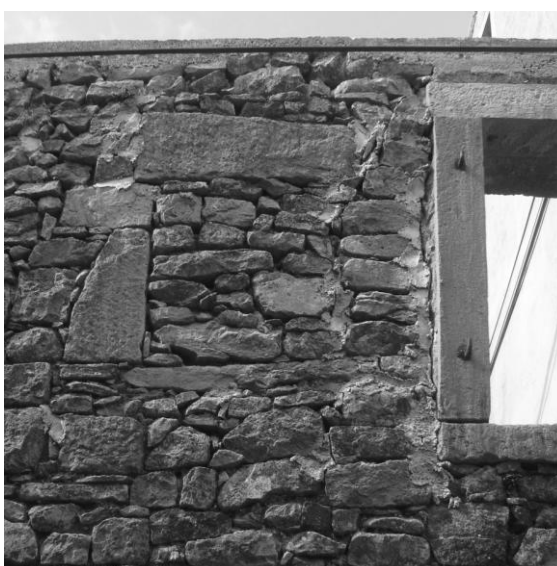
Slika 39., Buzet, kuća iz 18. st., zazidani prozor
