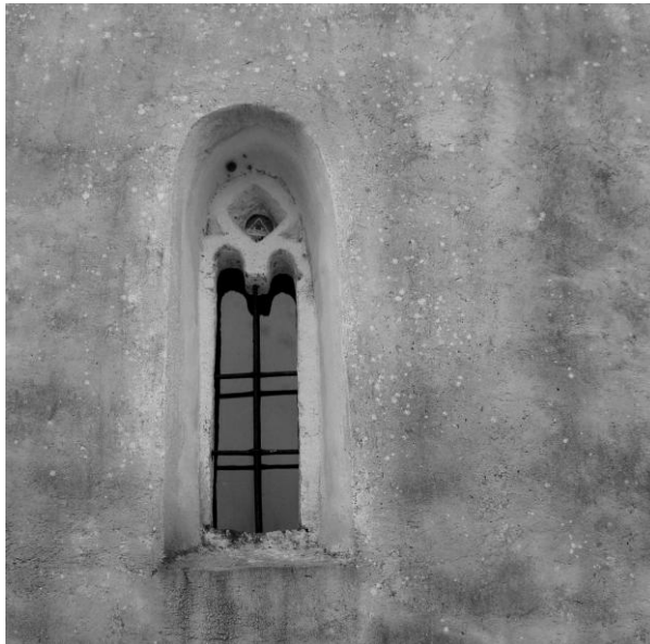
Slika 55., Oštećena tranzena na istočnom zidu broda
