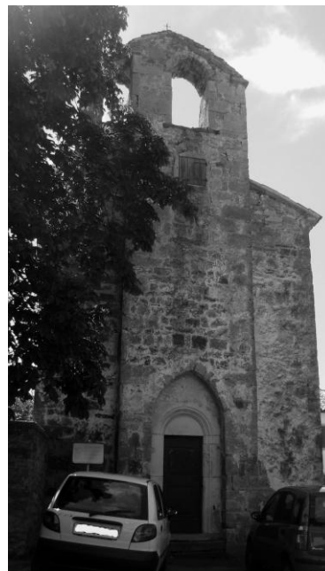
Slika 23., Roč, pročelje s preslicom sv. Antuna opata
