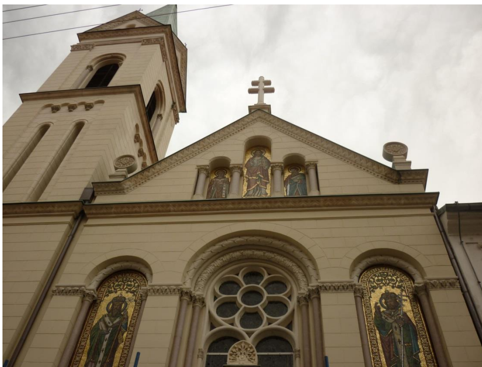
Sl 15. Pročelje i zvonik nakon radova
