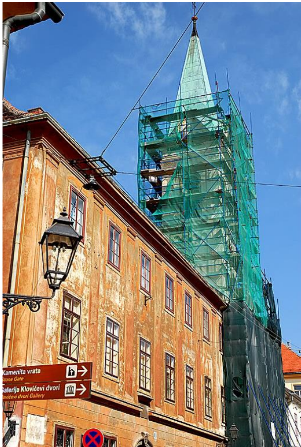
Sl. 6. Zgrada sjemeništa prije obnove, istočno pročelje.
