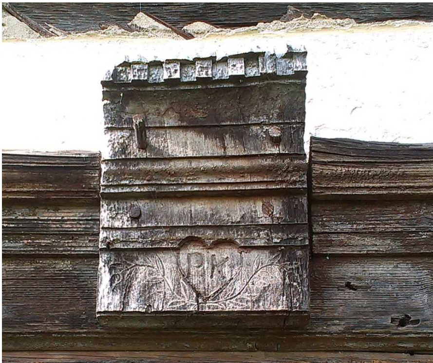
Slika 9 – izrezbareni inicijali iznad glavnog ulaza kurije Alapić, Vukovina.
