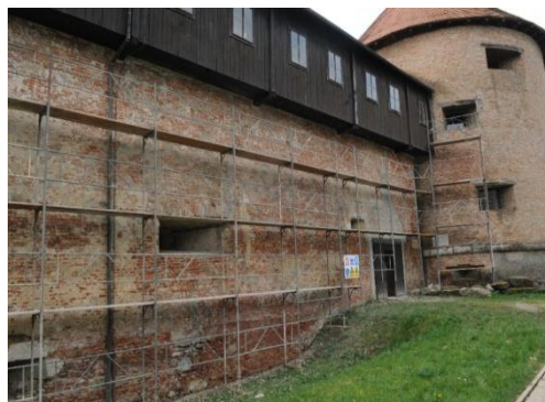
Slika 29. Radovi na vanjskim zidovima Utrvde
