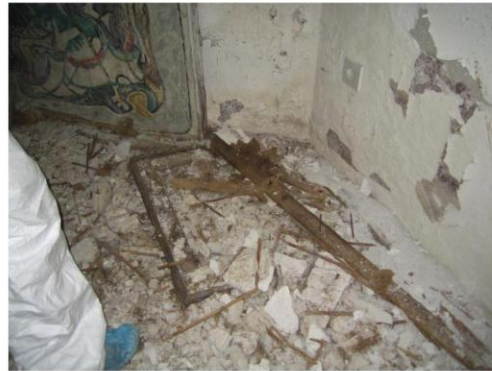
Zatečeno stanje slike Zarobljenik ispod naslaga maltera i šuta
