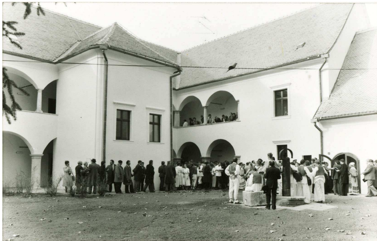
Sl. 7. Dvorište palače Sermage sa pogledom na dograđeno stubište (GMV)
