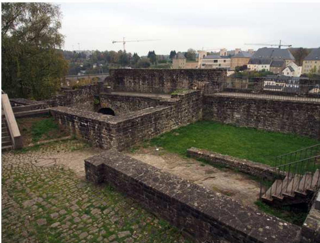
Slika 11: Zidane konstrukcije na stijeni Bock. Danas služe kao vidikovac. Osobna fotografija, 25.4.2015.
