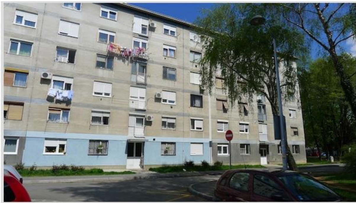
Slika 19. Obnova dijela fasade u dogovoru stanara pojedinog stubišta, Trnsko 30a-c.
