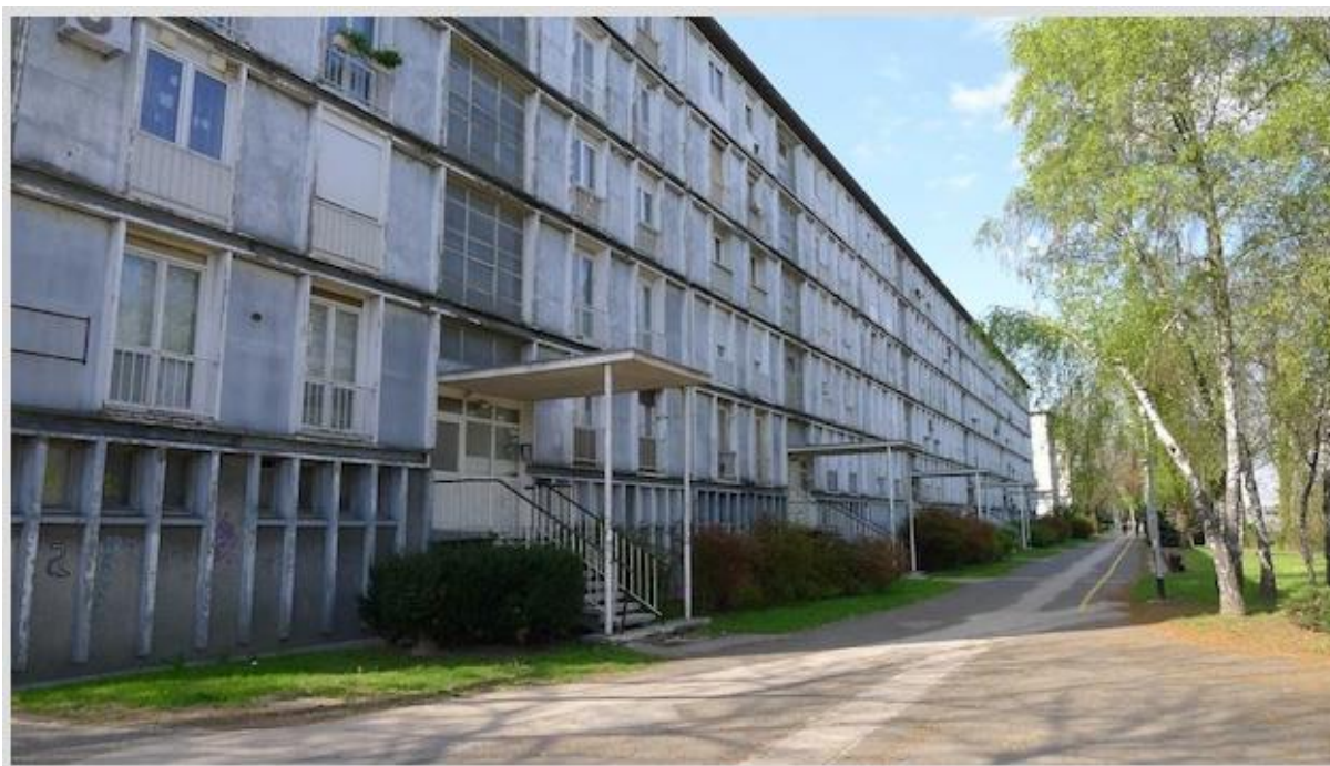
Slika 20. Stambeni objekt tipa „Volta“ na ulazu u naselje (Trnsko 1a-f). Arhitekt: Drago Korbar, o. 1964.
