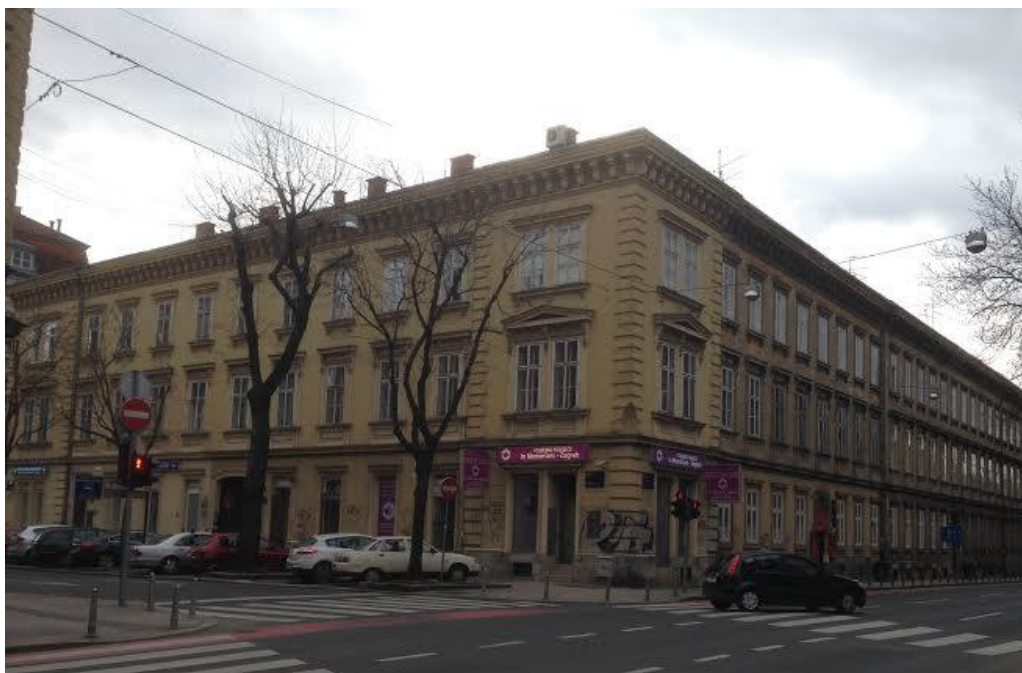
Slika 7 Istočno pročelje, pogled sa sjevera (vlastita fotografija)
