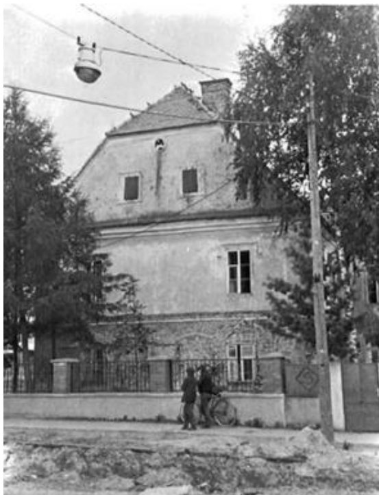
Slika 102. Sjeverno pročelje stare zgrade župnoga dvora u Prelogu (1768.)
