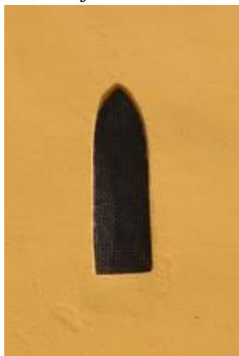
Slika 31. Mali prozor gotičkih stilskih osobina na zapadnom pročelju zvonika župne crkve sv. Jakoba u Prelogu
