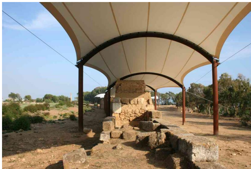
Slika 4. Novi pokrov nad zidinama u Capo Soprano, nakon što je uklonjena Minissijeva konstrukcija
