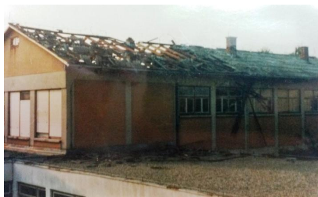
Slika 14 OŠ Ivana Brlić Mažuranić s oštećenim krovštem
