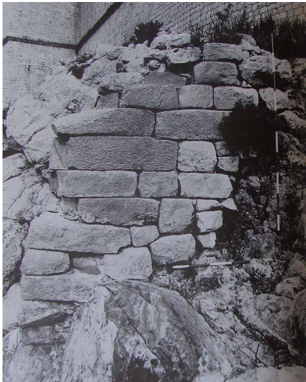
Sl. 14. „Baslerov“ zid (foto M. Mojaš)
