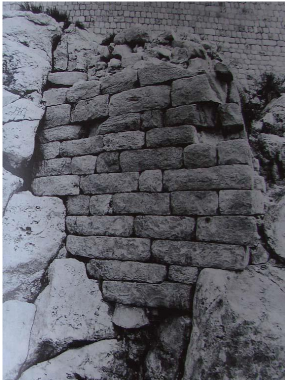
Sl. 13. „Baslerov“ zid (foto M. Mojaš)
