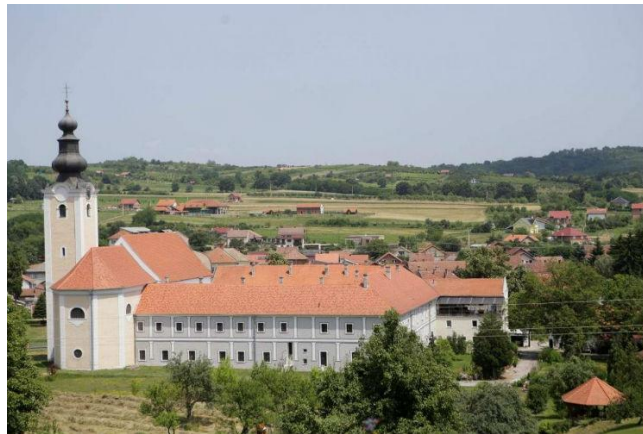
Slika 2 - Franjevački samostan u Cerniku
