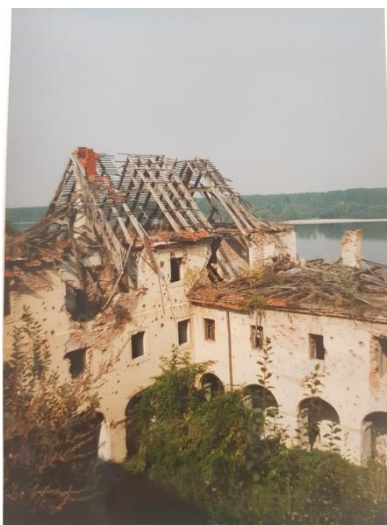
Slika 30. Pogled na razrušeni franjevački samostan u Vukovaru, 2. listopada 1997.g.
