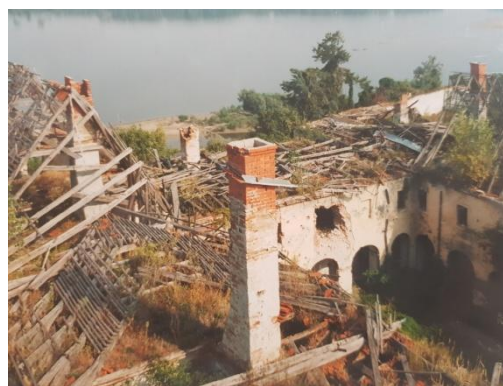
Slika 31. Pogled na razrušeni franjevački samostan u Vukovaru, 2. listopada 1997.g.
