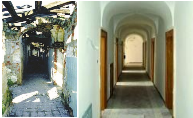
Slika 48. Samostanski hodnik prije i poslije sanacijskih radova
