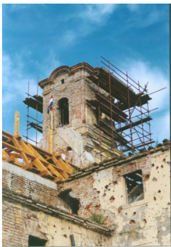
Slika 46. Zvonik u tijeku obnove
