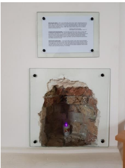
Slika 67. Rupa u zidu svetišta crkve u koju je bio postavljen eksploziv
