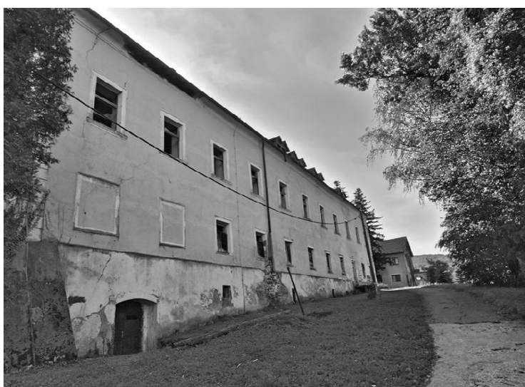
II. 12. Zajezda – začelje
