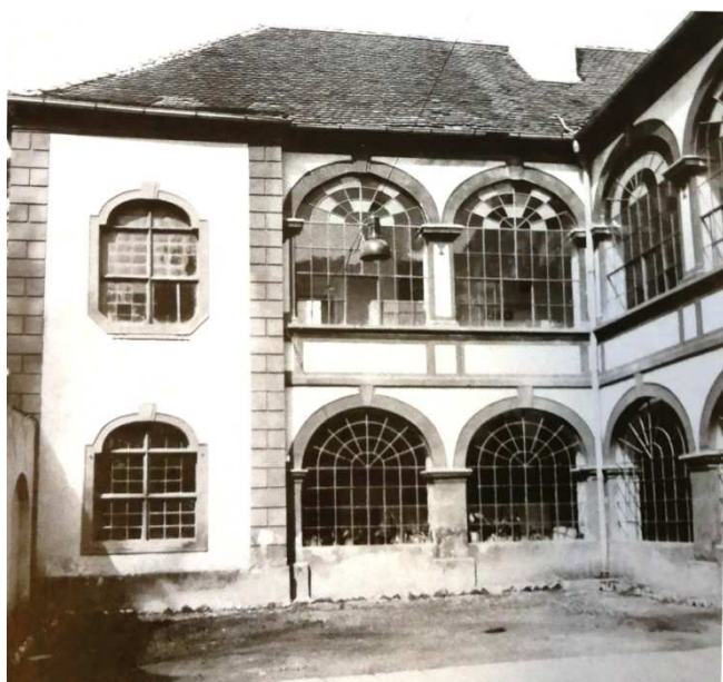
II. 11. Zajezda – bočno pročelje
