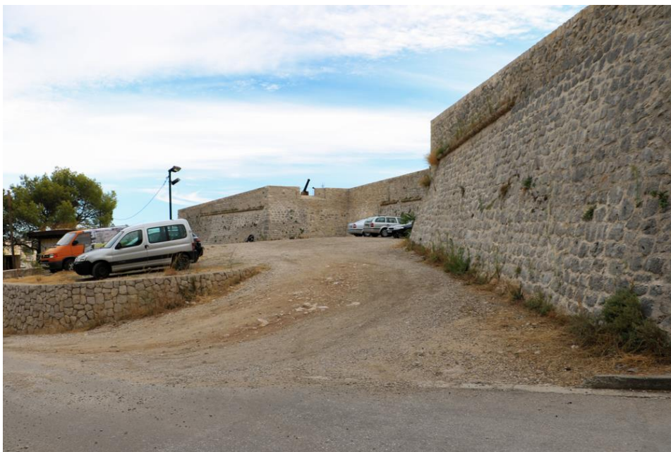
Slika 46. Parking tvrđave Barone, pogled s sjeverozapada
