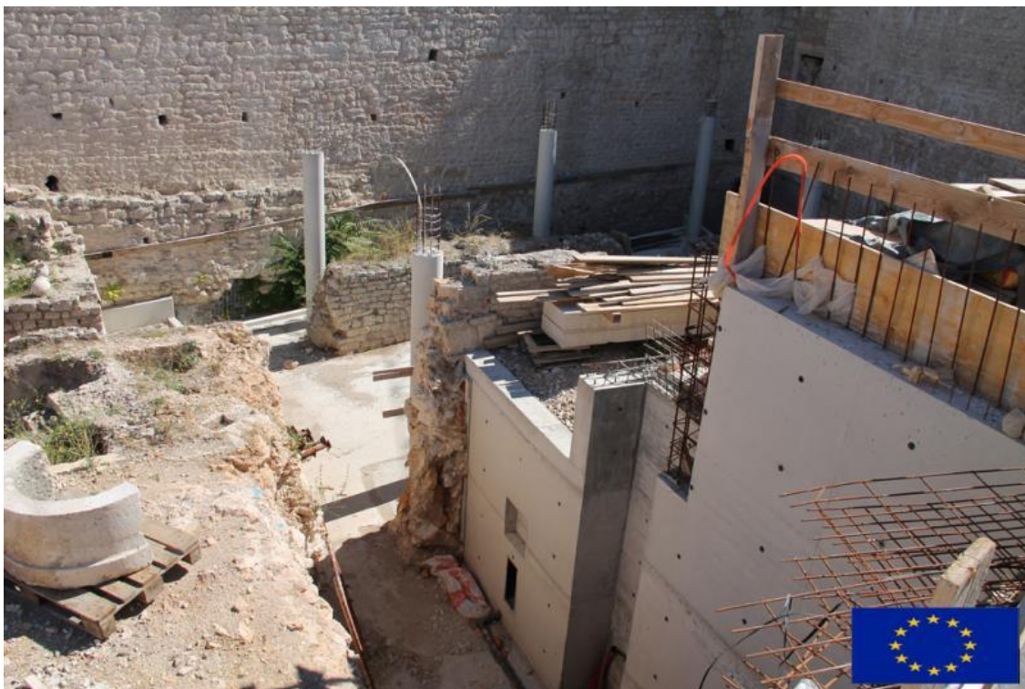
Slika 26. Iskapanja u živoj stijenu u svrhu izgradnje podrumskih prostorija
