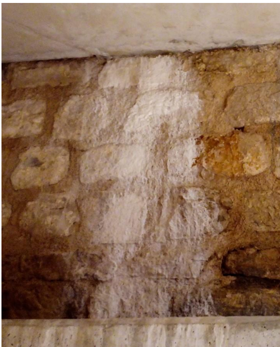
Slike 36 i 37. Izluživanje na istočnom zidu multifunkcionalne dvorane
