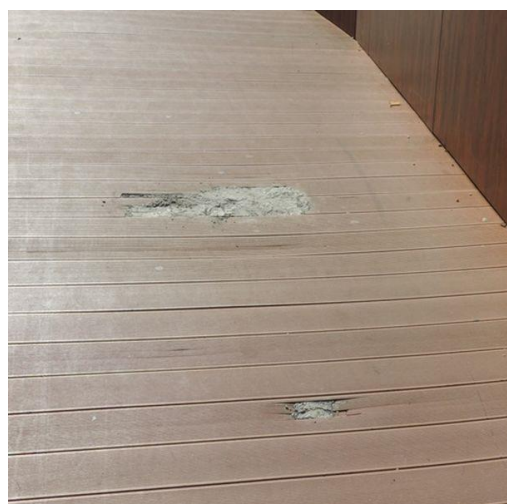
Slike 64 i 65. Oštećenja nastala uslijed upotrebe neprimjerenih materijala, plaža Banj
