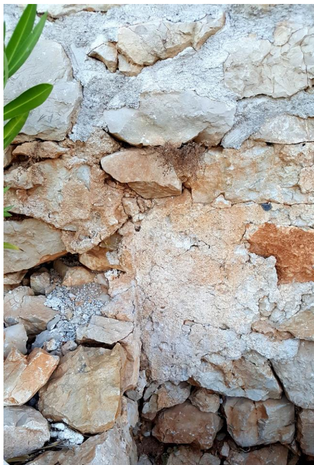
Slika 49. Ugradnja morta na sjeverozapadnom zidu sjevernog platoa tvrđave
