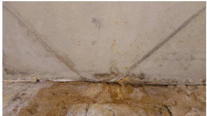
Slike 36 i 37. Izluživanje na istočnom zidu multifunkcionalne dvorane
