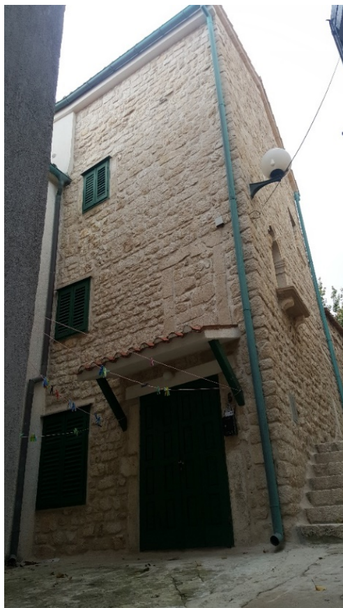
Slika 74. a) Građevina romaničke osnove u Ulici kneza Trpimira
