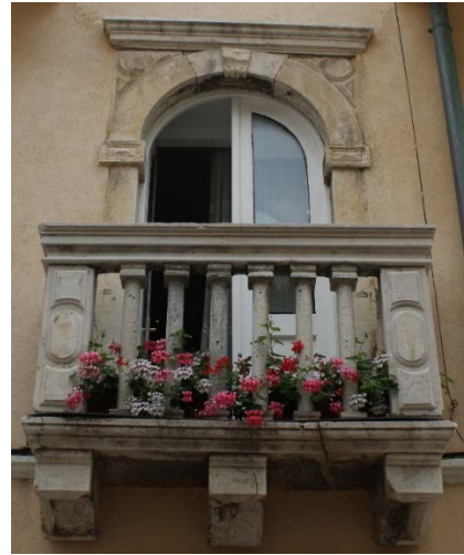
Slika 45. Balkon i balustrada kuće u Srednjoj ulici
