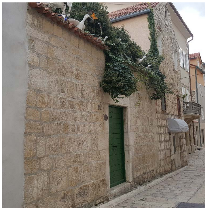
Slika 26. Dvorišni zid između dvije građevine
