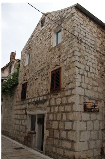
Slika 27. Građevina u istočnom dijelu kompleksa s plastično istaknutim trakama morta u prizemlju
