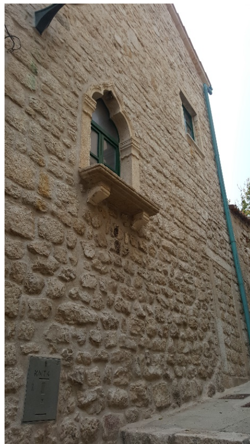
Slika 74. b) Građevina romaničke osnove u Ulici kneza Trpimira: ulična strana
