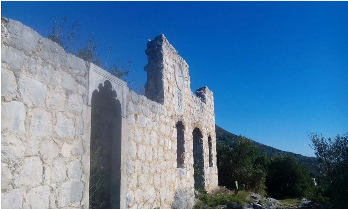
Slika 12. Umjetna ruševina na Drvarici sa ugrađenim elementima koji su se nalazili na prvotnom ljetnikovcu
