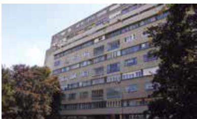
Neven Šegvić, Ivo Geršić, Višestambena zgrada „Kruge“ Ulica grada Vukovara 222 i 224, Zagreb 1953.-1960. Upis u Registar: 25. 04. 2013. Oznaka: Z – 5975
