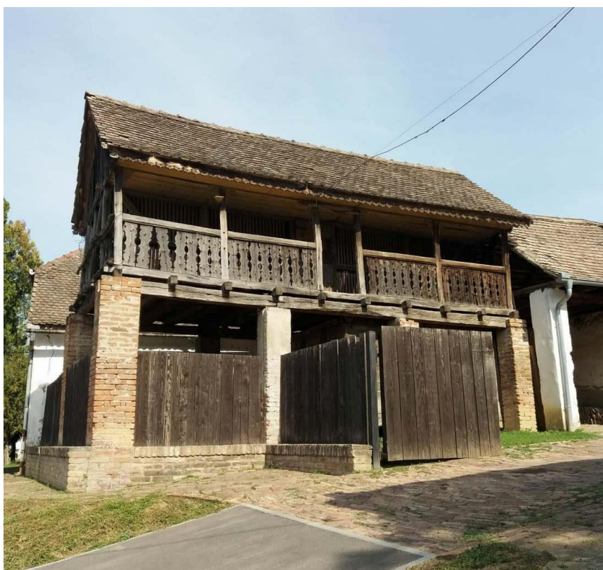
Slika 39. Srijemska kuća u Iloku. Čardak na ulazu u objekt. Snimila: Danijela Kovač, 11. rujna 2018. godine.
