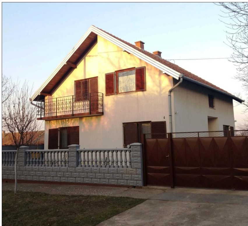
Slika 34. Bapska, Ulica Alojzija Stepinca 4. Kuća izgrađena krajem 80-ih godina XX. stoljeća. Primjer odstupanja od standarda tradicijske arhitekture: gradnja katnice koja je uvučena u odnosu na uličnu liniju. Snimila: Danijela Kovač, 14. veljače 2019. godine.
