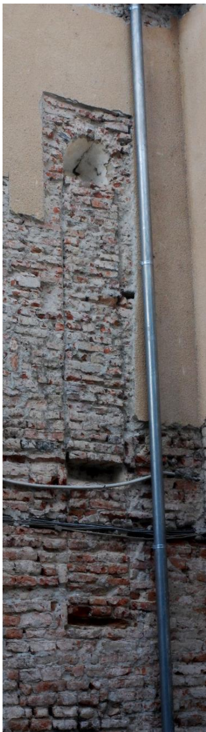
Sl. 55. Južni zazidani srednjovjekovni prozor, lijevo od baroknog prozora, na crkvi sv. Ivana Krstitelja u Ivankovu.
