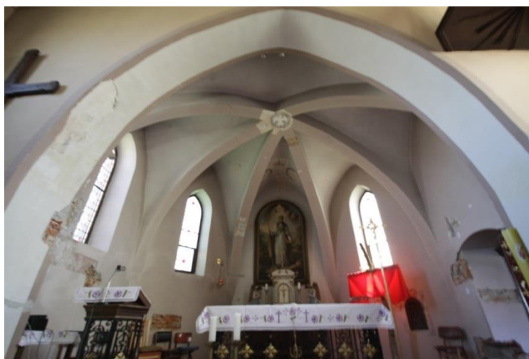
Sl. 63 i 64. Svodno rebro i konzola križno-rebrastog svoda crkve Uznesenja BDM u Dragotinu (lijevo) i Križno-rebrasti svod crkve sv. Grgura u Šljivoševcima (desno).
