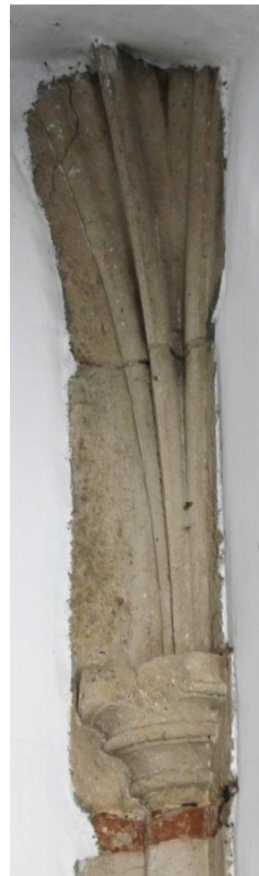
Sl. 214 i 215. Crkva sv. Petra i Pavla, Šarengrad: svod svetišta (lijevo) i kapitel sa svodnim rebrima u kapitularnoj dvorani (desno).
