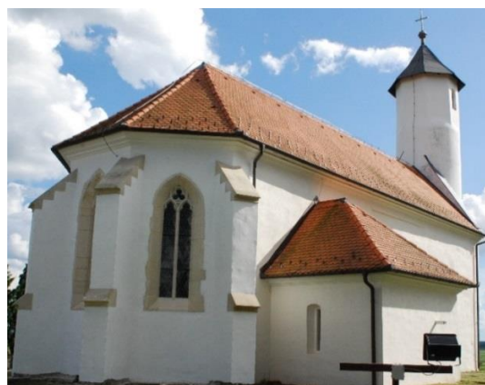
Sl. 41. Crkva sv. Bartola u Novim Mikanovcima, pogled sa sjeveroistoka.
