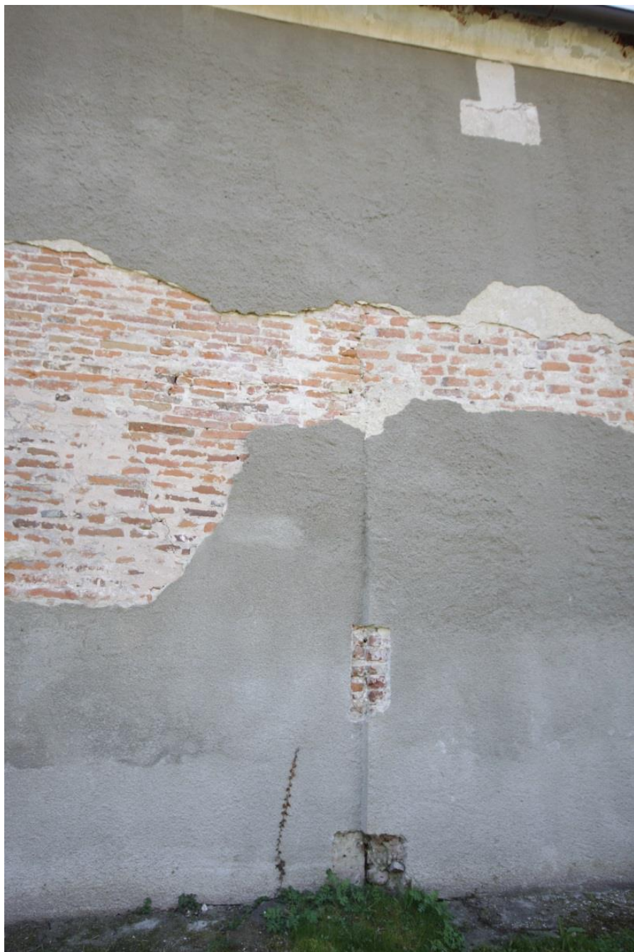
Sl. 177. Sjeverni zid broda crkve sv. Jurja u Svetom Đurđu - razlikuje se antička od kasnije opeke.
