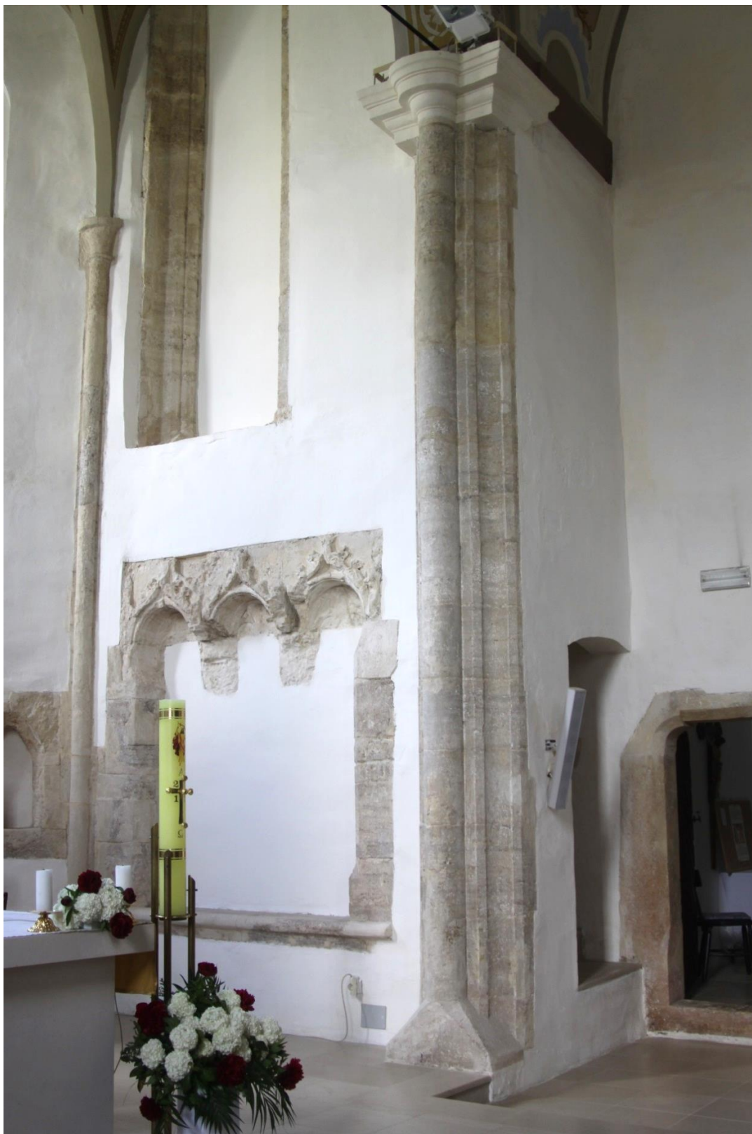
Sl. 217. Crkva sv. Petra i Pavla u Šarengradu - južna strana trijumfalnog luka, južna sedilija, polustup s kapitelom i imitacijom svodnog rebra.
