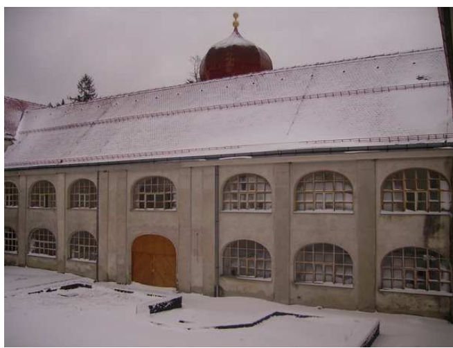
Slika 11. Dvorišno pročelje glavnog krila
