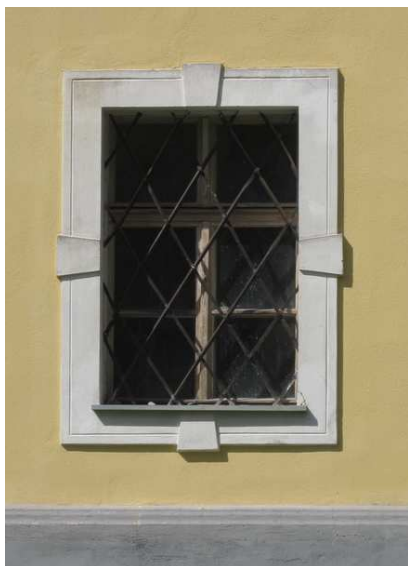
Slika 12. Prizemni prozor južnog pročelja
