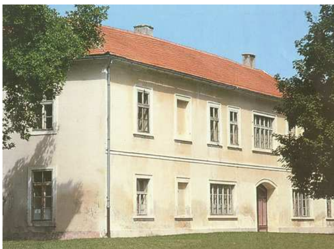
Slika 29. Dvorac u Pakracu, istočno pročelje
