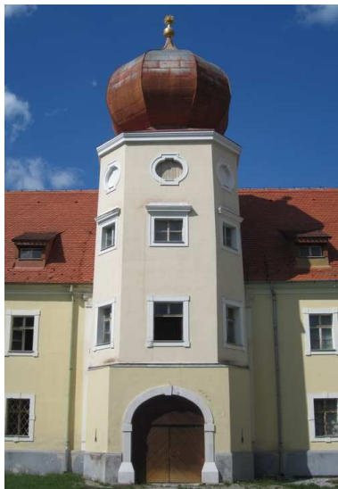
Slika 19. Današnji izgled ulaznog tornja
