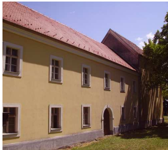
Slika 7. Pročelje zapadnog krila
