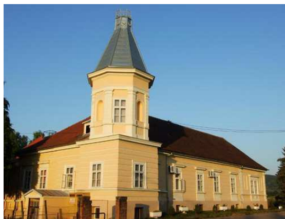
Slika 32. Kurija u Brestovcu, pročelje
