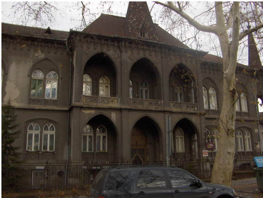
Slika 12. Glavno pročelje palače Lichtnekert
