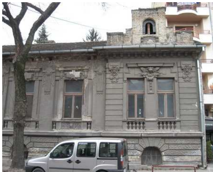
Slika 53. Dio pročelja kuće na broju 13.
