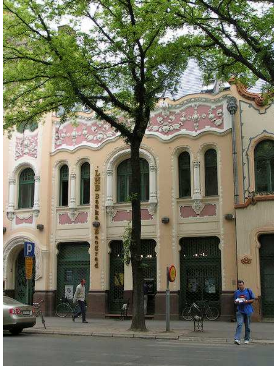
Slika 37. Današnji izgled pročelja palače
