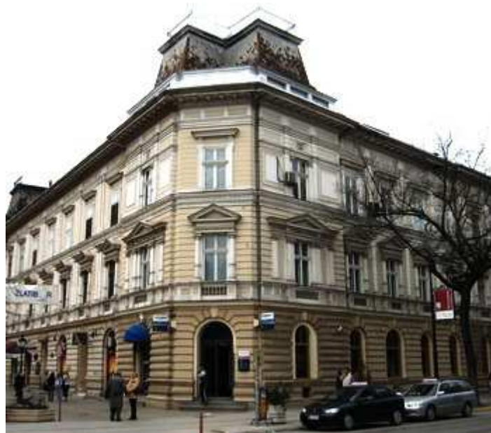
Slika 8. Pogled na glavni ulaz i pročelja
