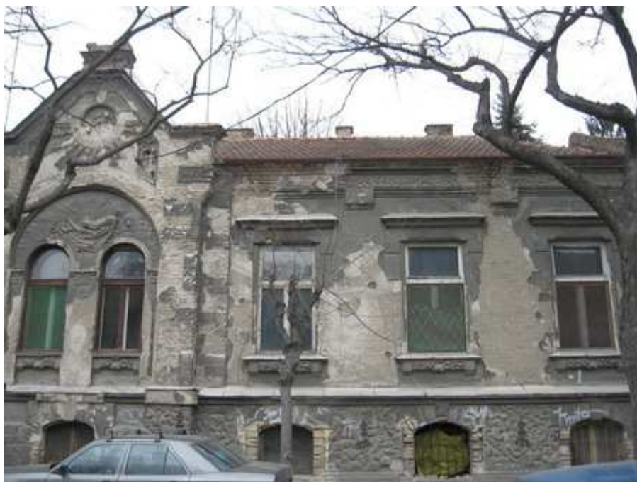
Slika 54. Dio pročelja kuće na broju 11.
