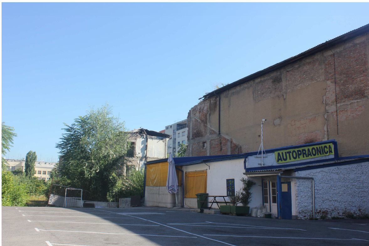
Slika 20: Pogled prema urušenoj dvorišnoj zgradi tvornice i nadogradnji sa zapadne strane, 2013.
