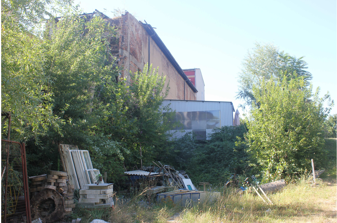
Slika 21: Detalj urušenog dijela dvorišne zgrade i prislonjene nadogradnje (autopraona), 2013.
