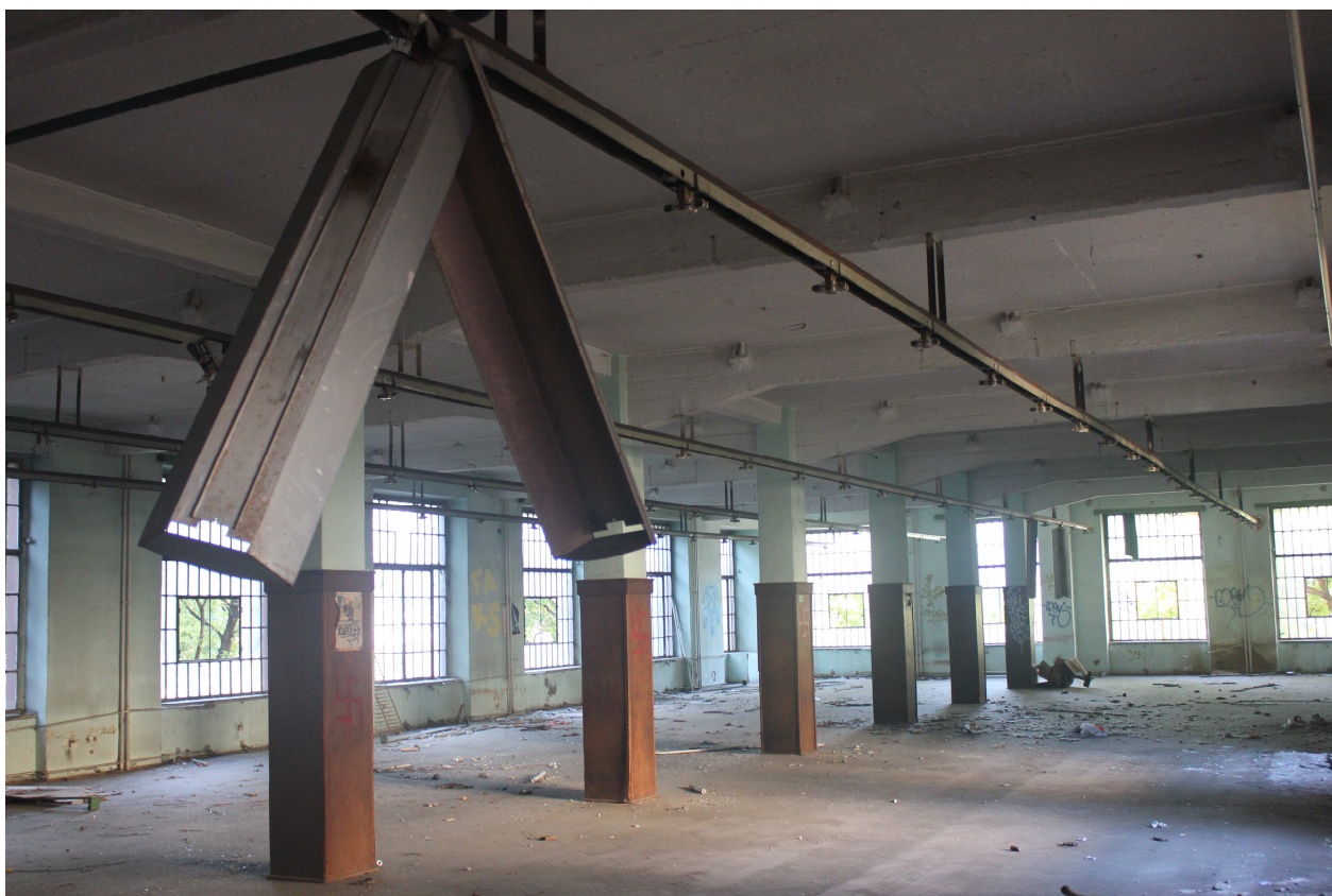
Slika 36: Tvornička hala u ugaonom dijelu zgrade na 1. katu, 2013.
