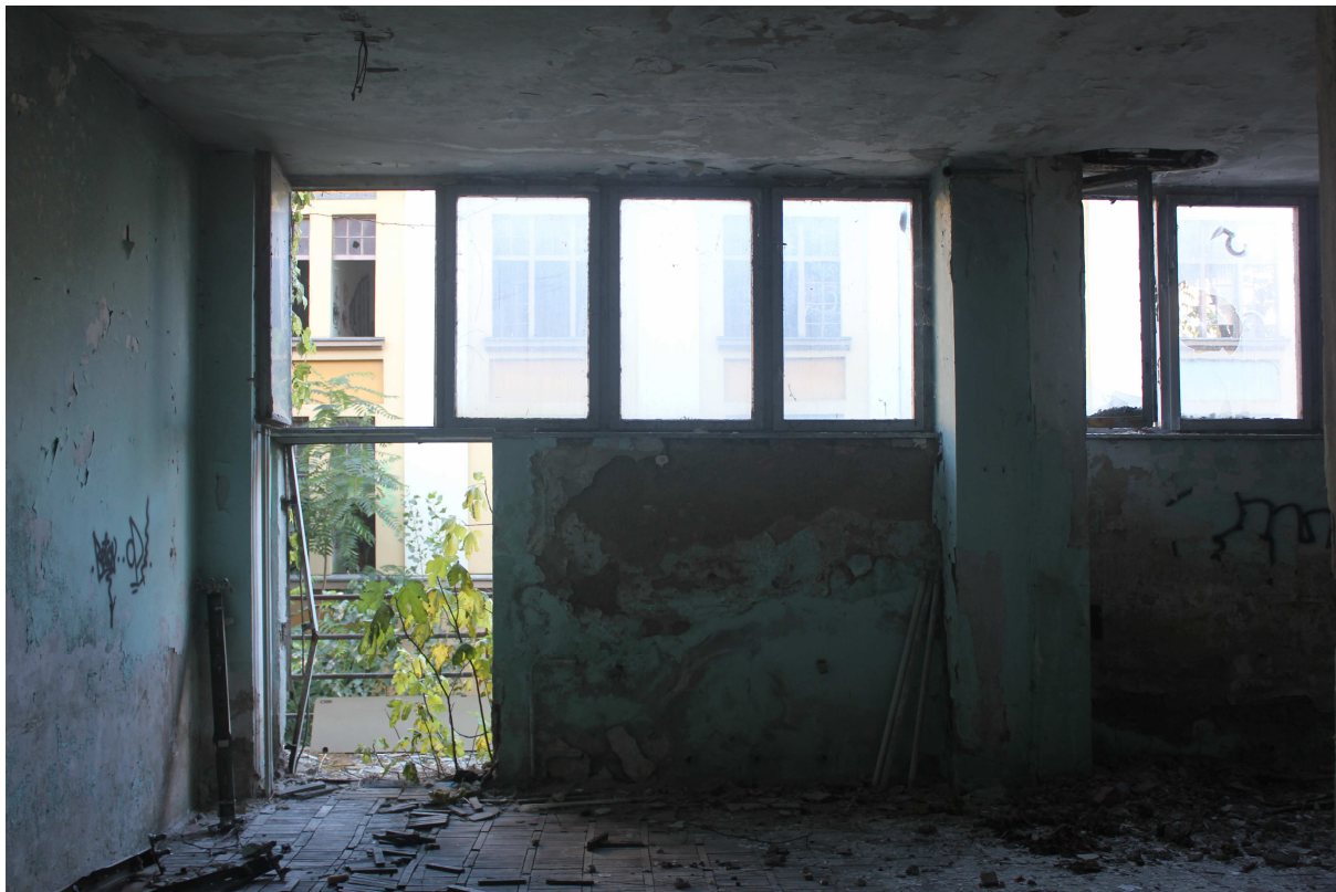
Slika 26: Oštećenja u unutrašnjosti tvorničke zgrade (1.kat), 2013.
