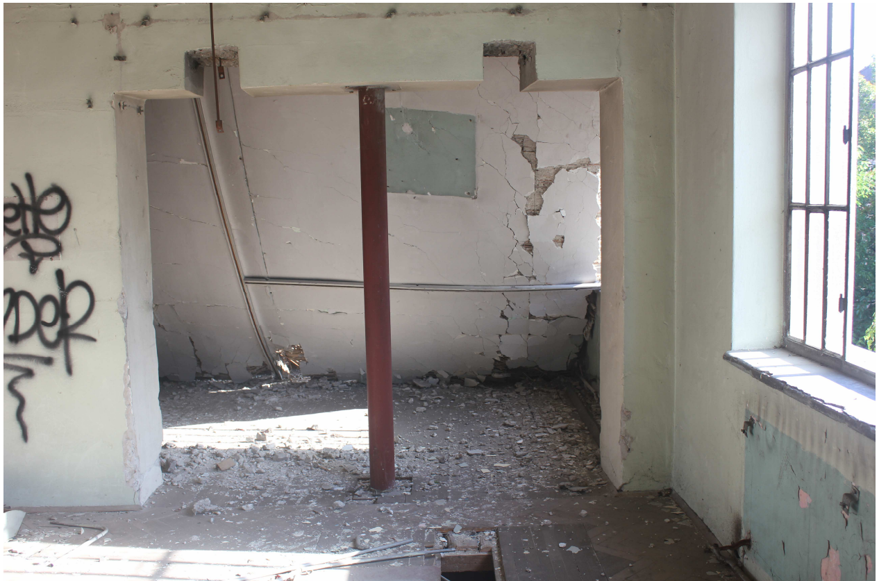
Slika 32: Urušeni strop u 3. katu tvornice u ugaonom dijelu zgrade, 2013.
