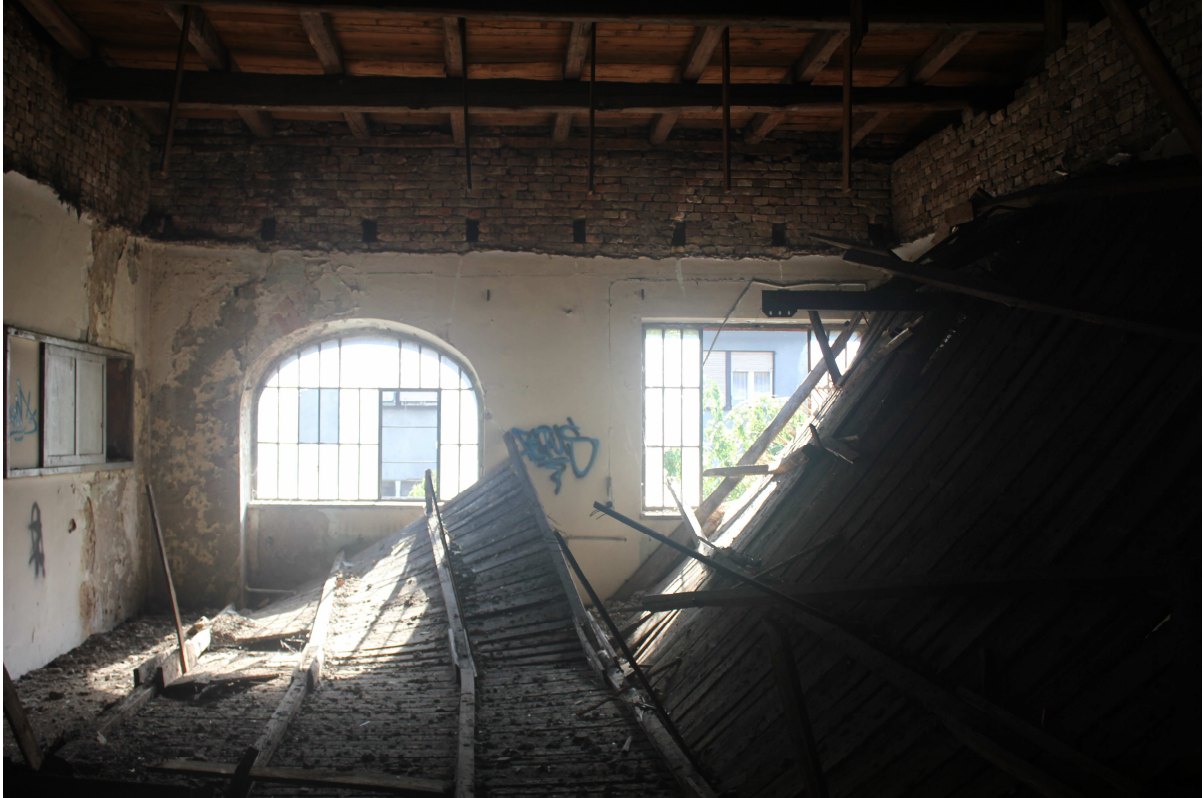
Slika 31: Urušeni strop u prostoriji 2. kata koja gleda na Erdödyjevu ulicu, 2013.
