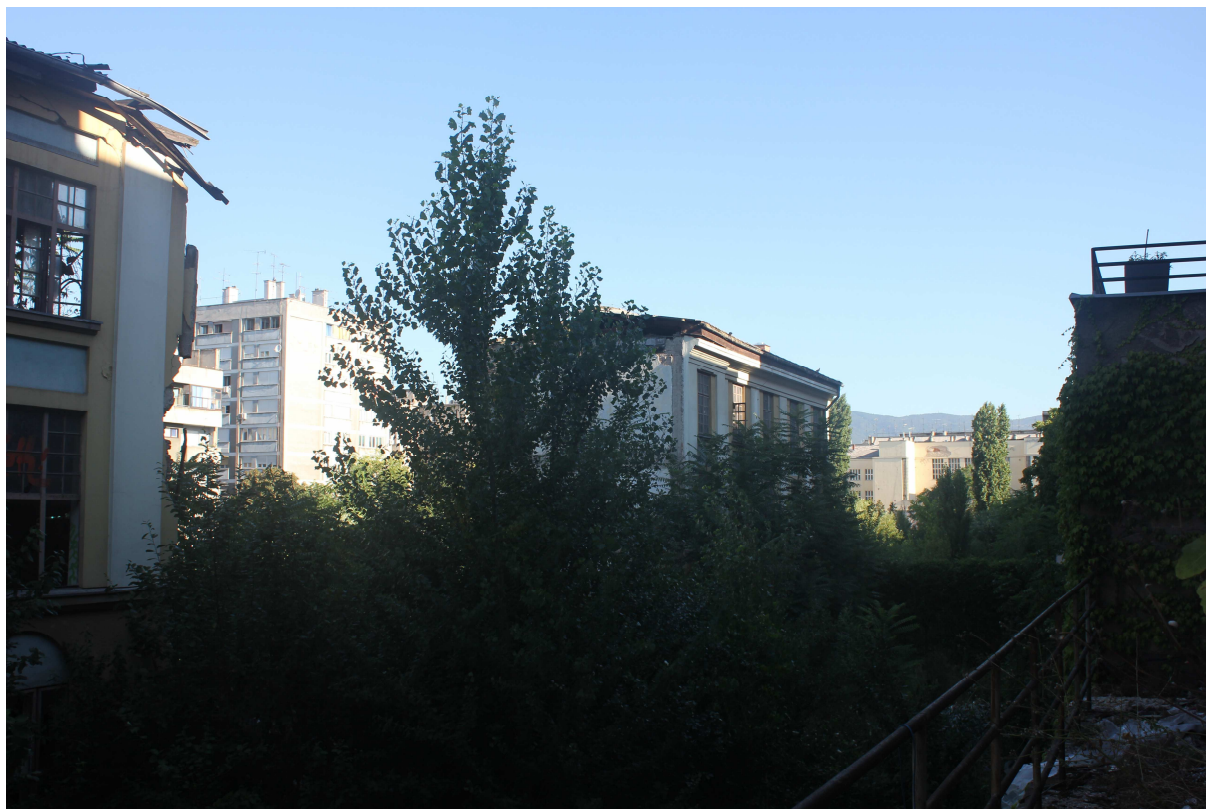
Slika 30: Pogled s balkona 1.kata tvornice prema urušenom dijelu dvorišne zgrade, 2013.
