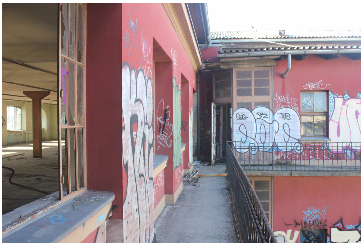
Slika 34: Pogled prema ugaonoj tvorničkoj hali s balkona na dvorišnoj strani zagrede (3.kat), 2013.
