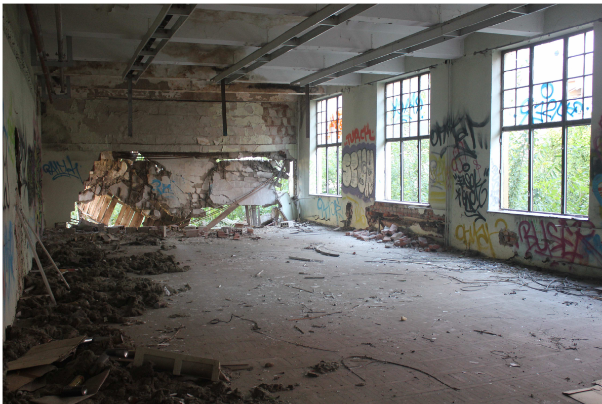
Slika 29: Urušeni zidovi u 2. katu dvorišne zgrade tvornice, 2013.
