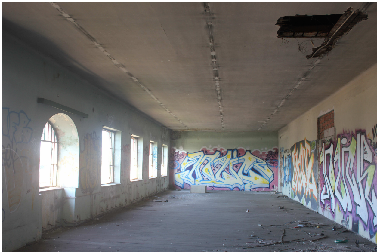
Slika 35: Tvornička prostorija na 3. katu s pogledom na Branimirovu ulicu, 2013.
