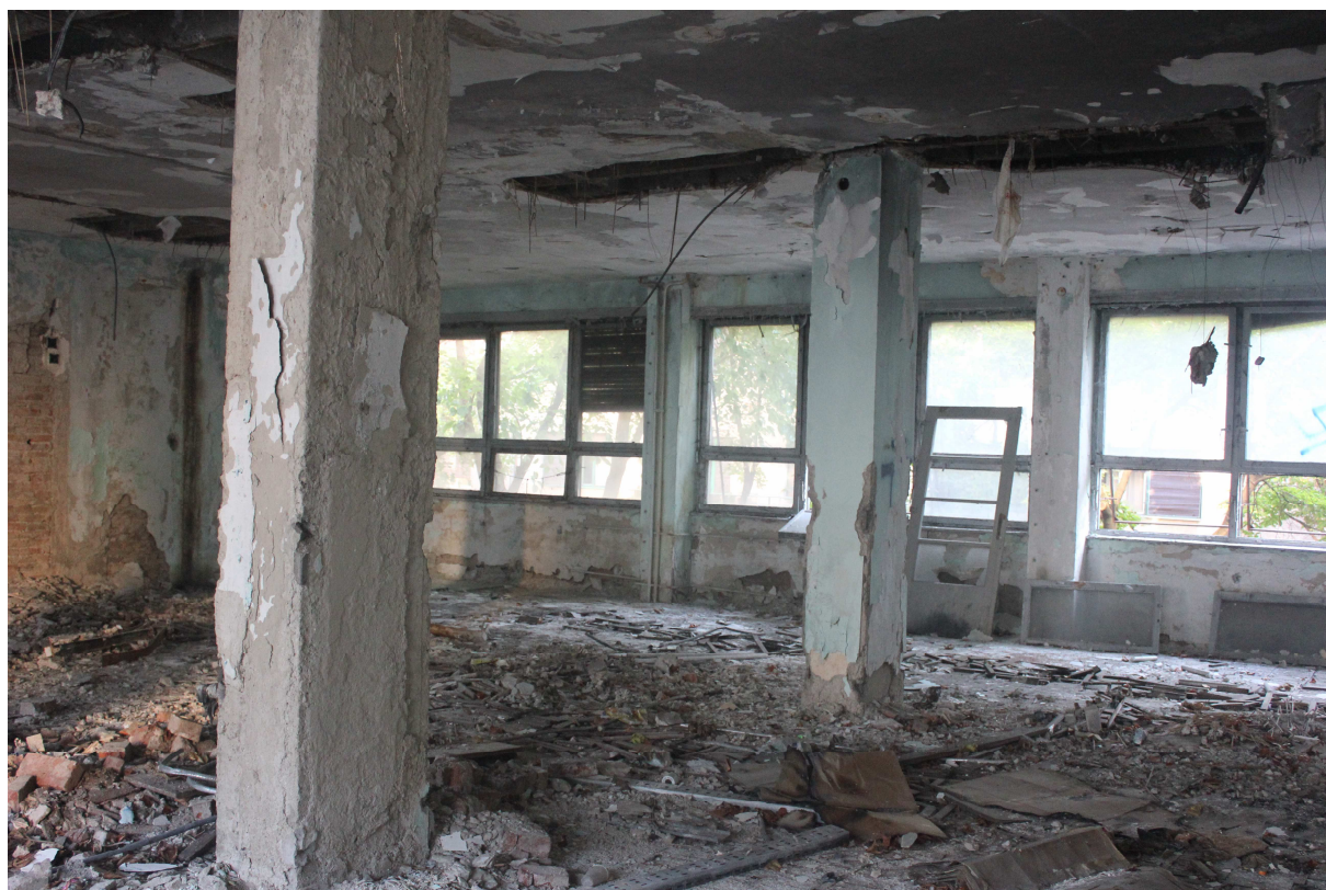
Slika 25: Oštećenja u unutrašnjosti tvorničke zgrade (1.kat), 2013.
