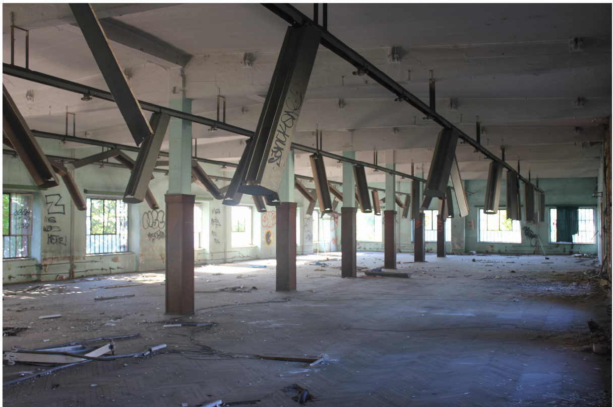
Slika 38: Tvornička hala u ugaonom dijelu zgrade na 2. katu, 2013.
