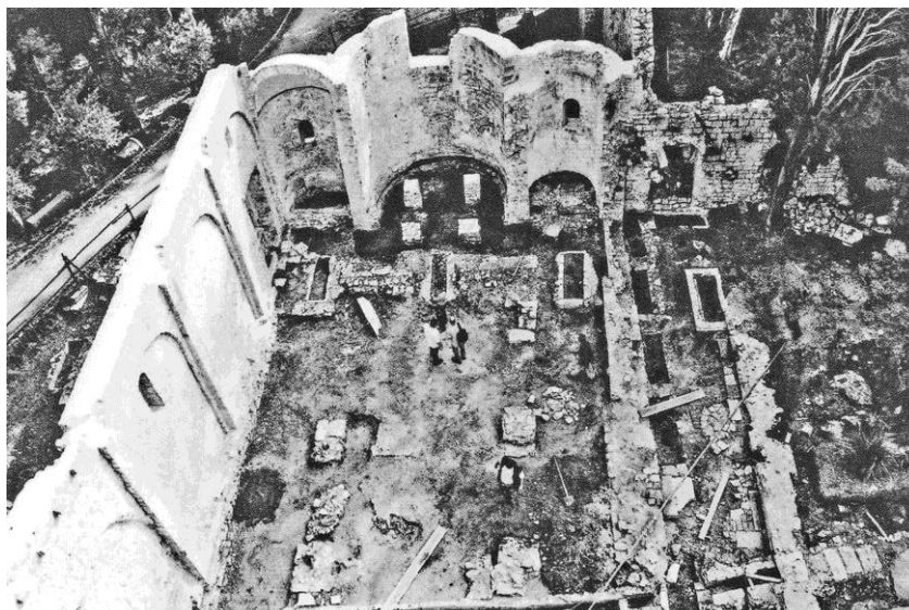
Sl. 19. Crkva sv. Marije na Lokrumu, sačuvani sjeverni zid i apside
