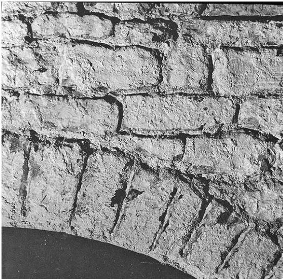
Sl. 36. Način obrade zida, sjeverni zid srednjeg broda, katedrala sv. Tripuna Kotor
