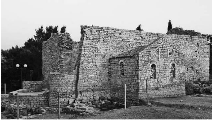
Sl. 35. Crkva sv. Petra, Osor, prostorija prigradena uz istočnu stranu sjevernoj zida
