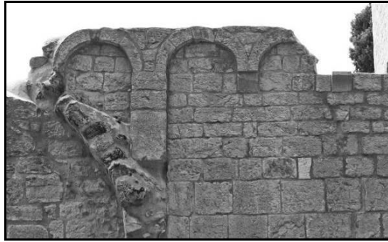
Sl. 23. Viseći lukovi, sjeverni zid, crkva sv. Marije na Lokrumu
