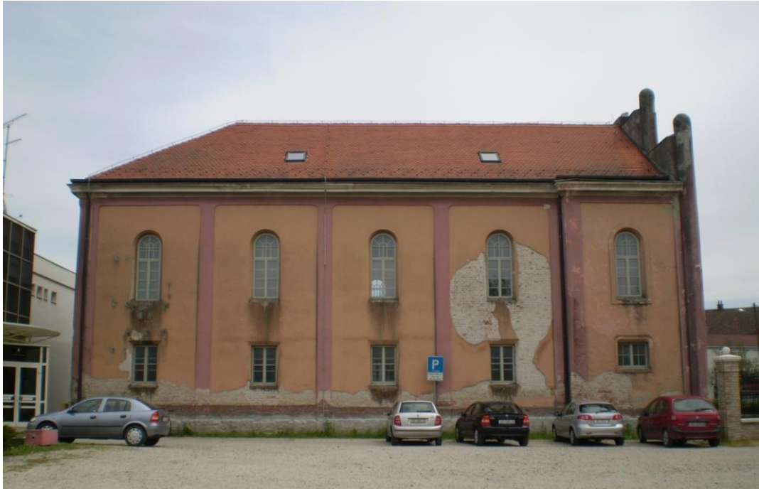
Slika 56.: Zapadno pročelje, stanje danas
