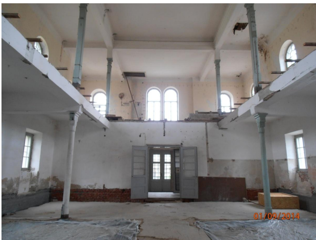
Slika 46.: Pogled sa svetišta prema ulazu i na galeriju
