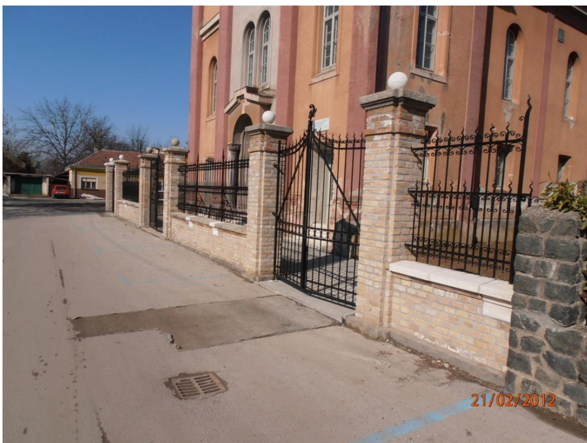
Slika 55.: Restauracija ograde i prednjeg dijela dvorišta
