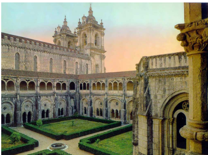
Figura 4 Claustro e fachada sul da igreja em Alcobaça
