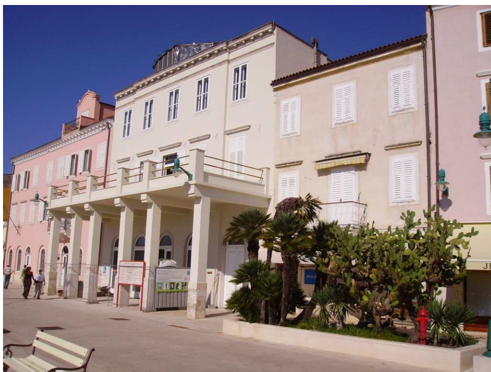
Sl. 14 Fotografija obnovljenog pročelja Palače Kvarner
