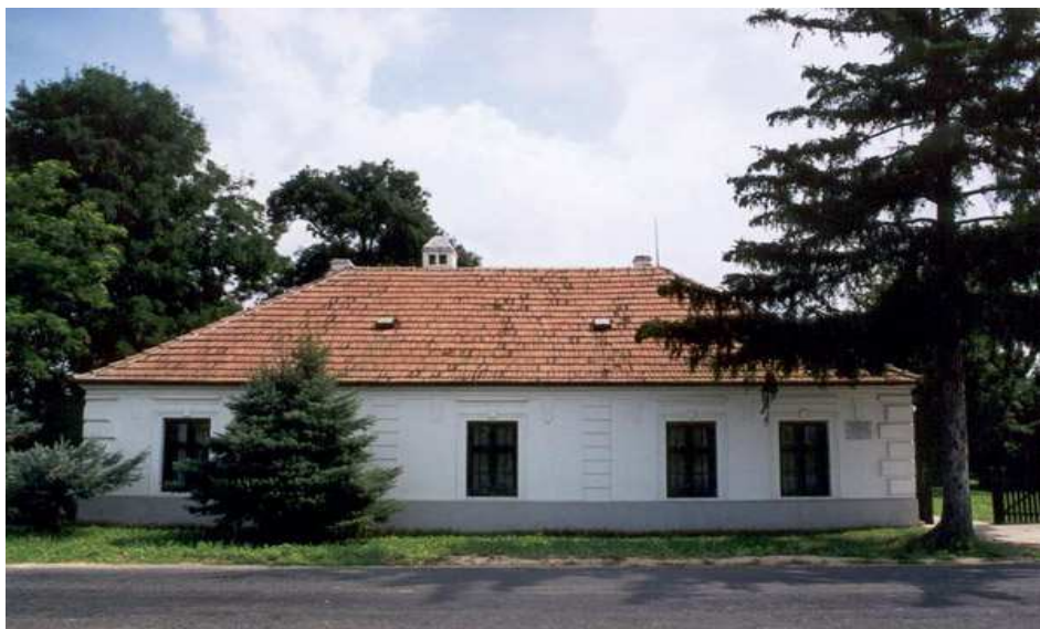
Slika 2. Kuća obitelji Nagy u Felsőiskázu (danas Iszkáz)
