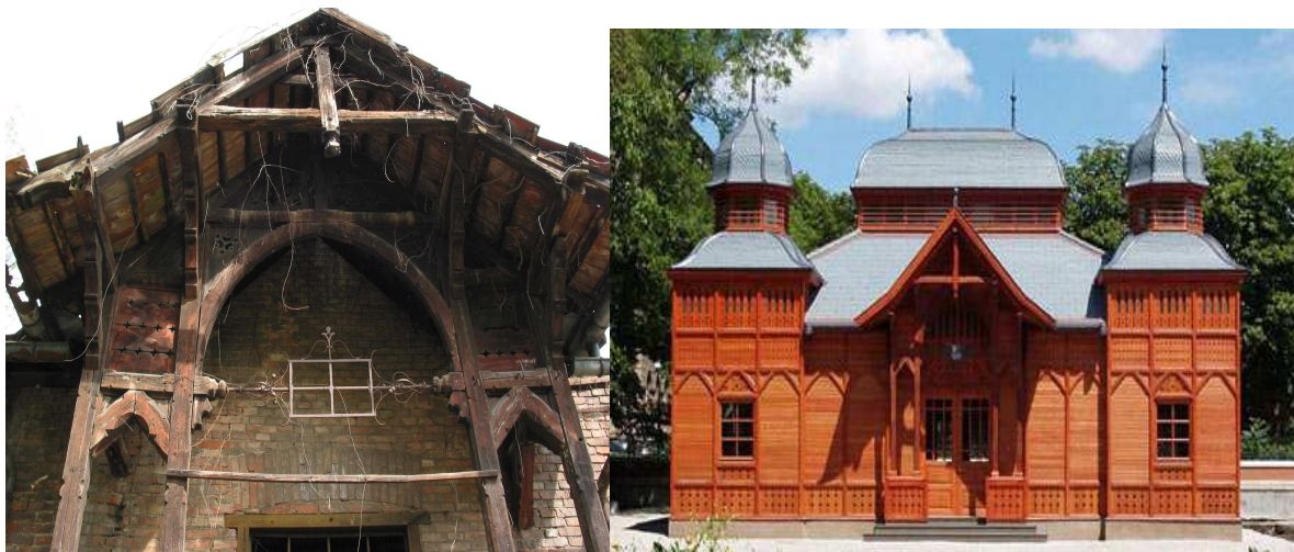
Slika 10. Izložbeni paviljon Botaničkog vrta prije i nakon obnove
