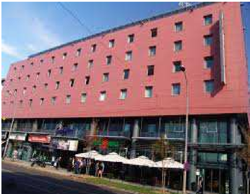
Slika 12. Novoizgrađeni Branimir centar
