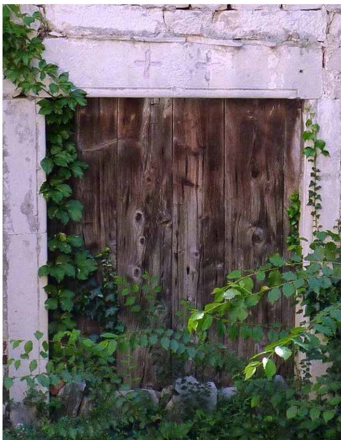
Slika 102: Gotički okvir vrata na kući kat.č. 213
