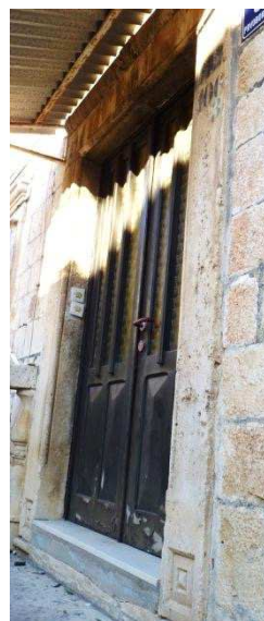
Slika 198: Ulazni portal prvog kata kuće (kat. čest. 14)
