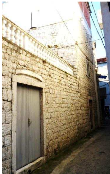
Slika 177: Kuća Zečić (kat. čest. 232-233)
