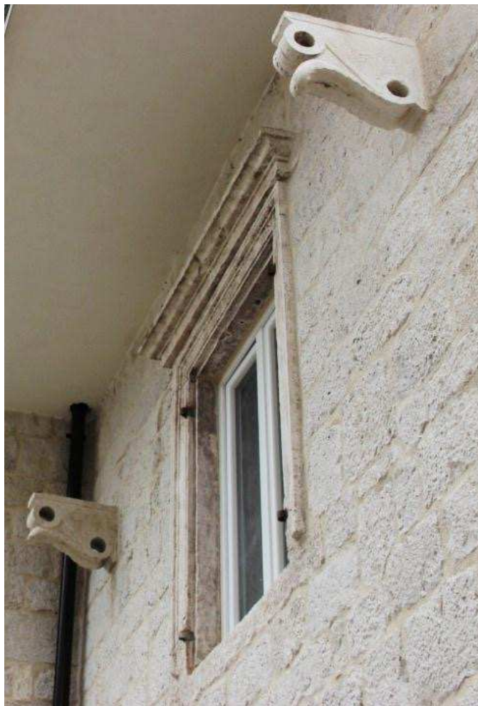
Slika 170: Kuća Rubinjoni (kat. čest. 251), detalj prozorskog otvora
