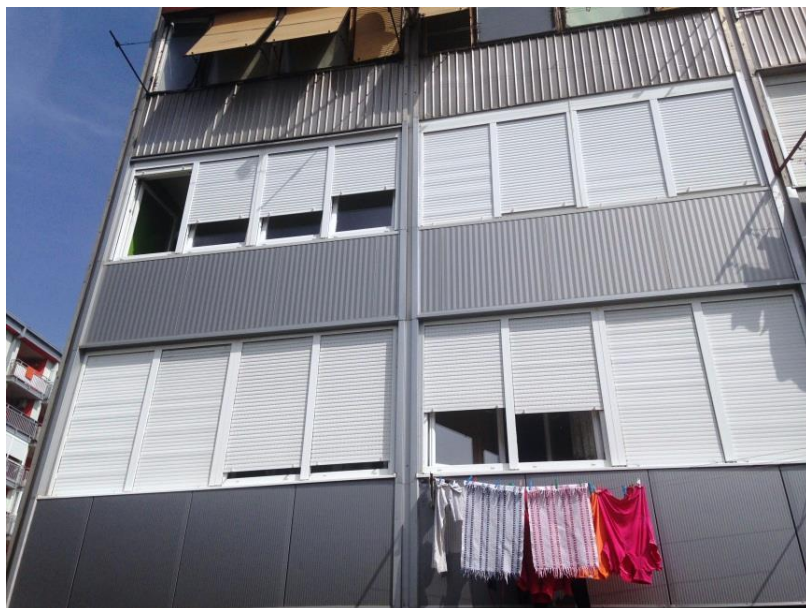
Slika 21. Pozitivan primjer obnove membrana pročelja, Remetinečki gaj, 2015.
