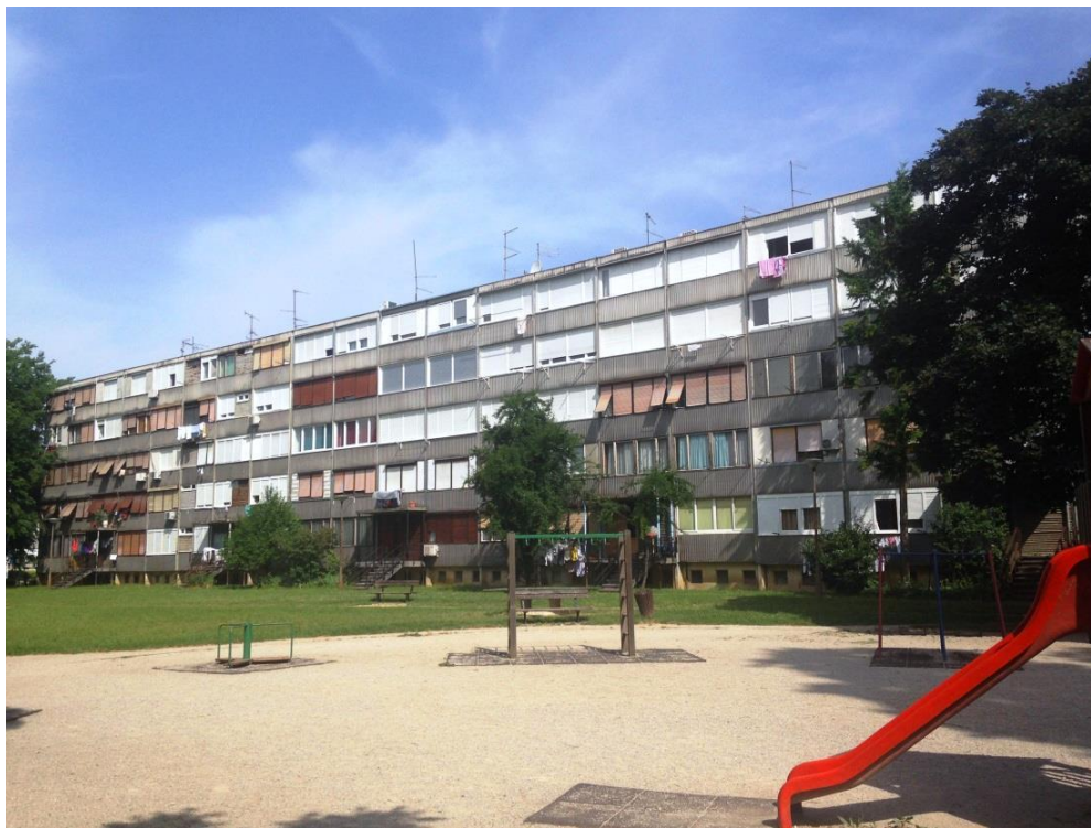
Slika 15. Zgrade građene sistemom Ju-61, Remetinečki gaj, 2015.
