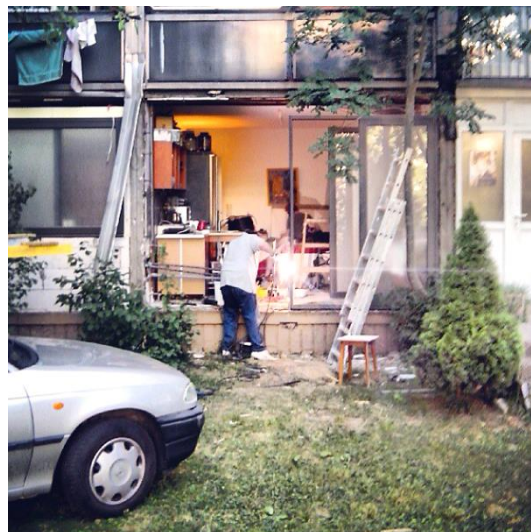
Slika 18. Obnova membrane pročelja, 2013.
