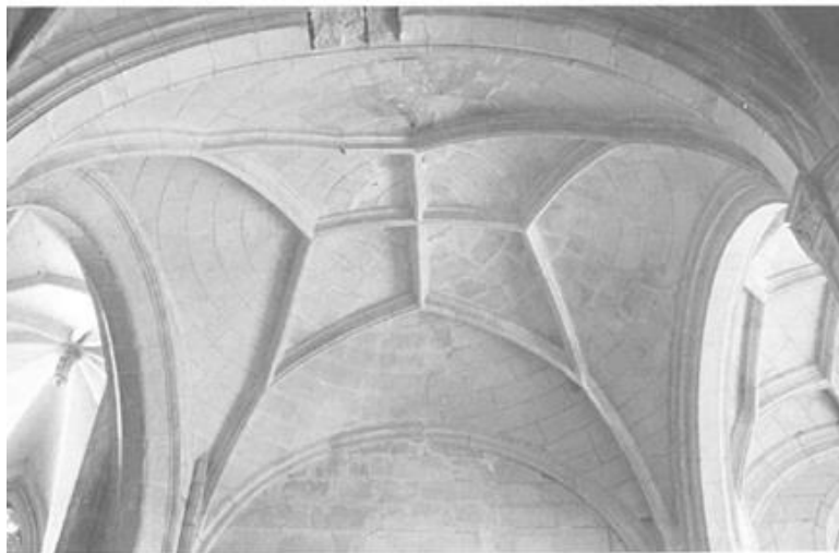
Sl. 12. Tonnerre, Saint-Pierre, južni bočni brod, detalj svoda
