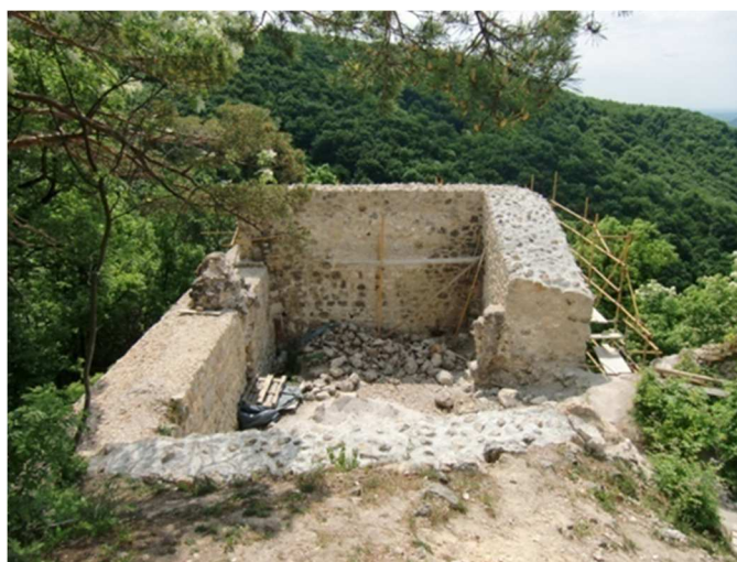
Slika 5. Kapela nakon sanacije zidova 2015. godine (foto:K. Ivanek)
