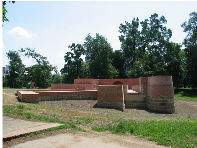
Slika 37. Današnje stanje južnog bastiona sa različitim visinama zida i prikaz produbijvanja terena s vanjske strane bastiona. Uz to primjetno je korištenje različitog građevinskog materijala. Vanjsko lice flanki i fasa građeno je od kamenih blokova, dok je unutarnji dio bastiona građen od lomljenog kamena i opeke. (foto: arhiva – Muzej Medimurja Čakovec, 2003.)
