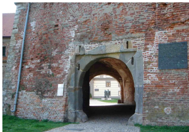
Slika 18. Današnje stanje vanjskog portala ulaznog bastiona sa sačuvanim otvorima za lance pokretnog mosta koji je bio ključna točka u gradskom komuniciranju. Vidljiva je zamjena
