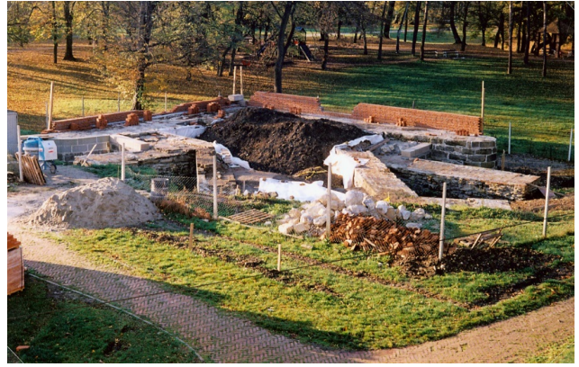
Slika 39. Stanje južnog bastiona za vrijeme građevinskih radova 2002. podizanja temeljne zone i gradnje vanjskih zidova fasama opekom. (foto: arhiva – Muzej Medimurja Čakovec, 2002.)
