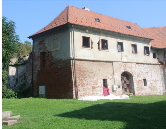
Slika 11. Današnje stanje a) pročelja sjeverozapadnog bastiona koji je u prizemlju zadržao izvornu formu i izgled s kamenim vijencem 16. stoljeća, u gornjem dijelu je barokna zgrada prigradana u 18. stoljeću s nizom pravokutnih otvora. b) Pogled na zapadni zid sjeverozapadnog bastiona uz koji je nekada bilo sagrađeno vanjsko stubište, vjerojatno po uzoru na drvena stubišta ulaznog bastiona s dvorišne strane. (fotograf: T. Vidović, 2016.)
