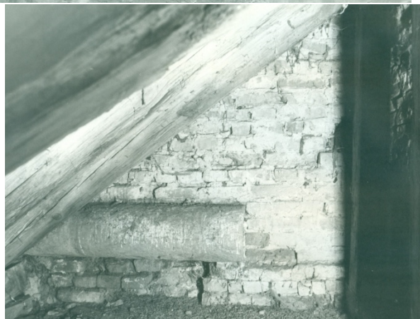
Slika 13. Stanje dvorišne strane sjeverozapadnog bastiona za vrijeme konzervatorskih radova 1989. godine s prikazom kamenog vijenca koji se probija kroz zid barokne zgrade otvoren sondom. To ukazuje na činjenicu da je izvorno zid prizemlja spomenutog bastiona bio duži. (foto: arhiva – Restauratorski zavod Hrvatske, 1989.)
