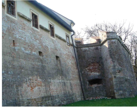
Slika 12. Vanjski zidovi sjeverozapadnog bastiona (I. dilatacija) sa očuvanim artiljerijskim otvorima pri temelju zida na kojima nisu vidljive naknadne promjene osim evidentnih višestrukih popravaka. Bez obzira na to, oštećenja su i dalje prisutna, stoga je ponovna sanacija neophodna. Na d) slici može se vidjeti tipologija sjeverozapadnog bastiona s uvučenim flankom i zaobljenim završetkom fasa (foto: T. Vidović, 2016.)
