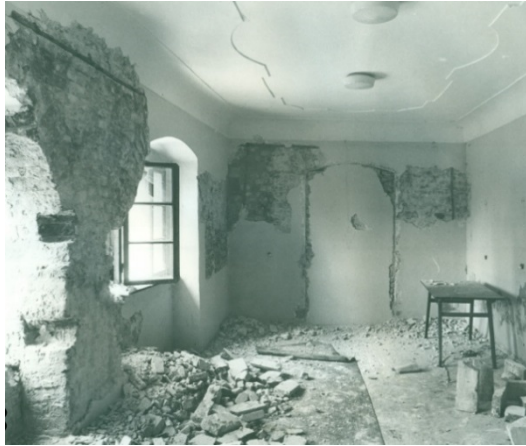
Slika 15. Stanje interijera na katu sjeverozapadnog bastiona za vrijeme konzervatorskih radova 1989. godina. Vidljivo je da su svi zidovi 16. stoljeća (građeni opekom) bili skriveni pod baroknom žbukom. Tragovi nekadašnjeg trijema galerije vidljivi su u manjim fragmentima interijera kata. (foto: arhiva – Restauratorski zavod Hrvatske, 1989.)
