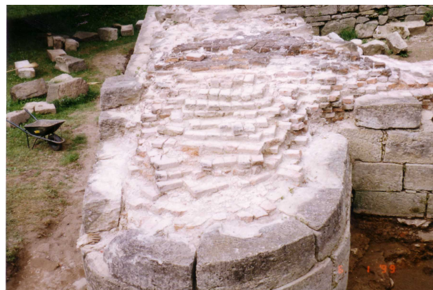
Slika 38. Stanje južnog bastiona (zaobljeni dio fasa) nakon arheoloških israživanja 1998. s prikazom građevinskog materijala koji se koristio. Vanjsko lice građeno je velikih kamenih blokova dok je njegova unutrašnjost građena od lomljenih kamenih ostataka i opeke. (foto: arhiva – Muzej Medimurja Čakovec, 1998.)
