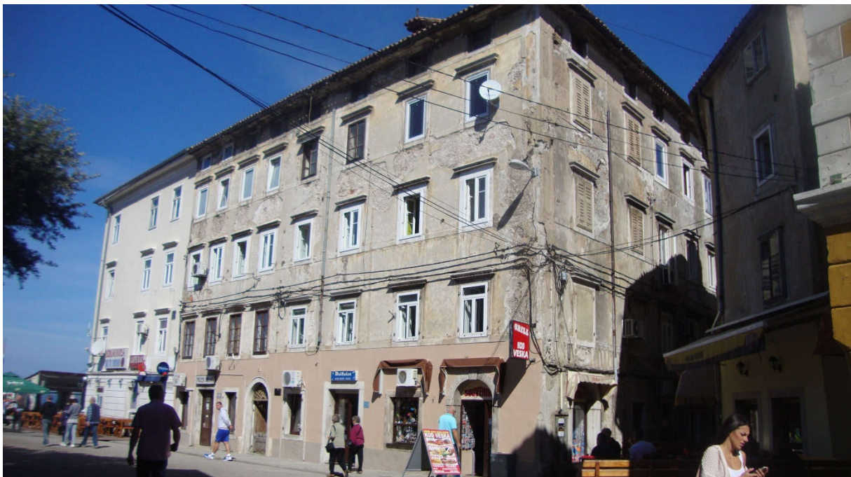
Slika 44. Zgrada nekadašnje Senjske štedionice, Senj, snimio Juraj Guić, 29.4.2014.
