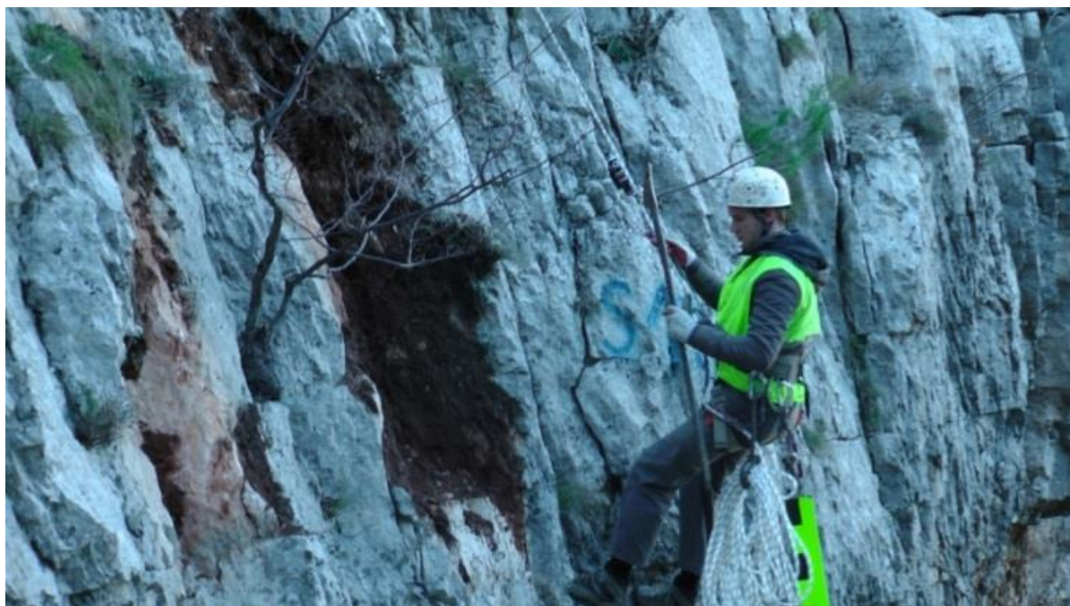
Sl. 36. Građevinska sanacija na okolnim stijenama – izoliranost položaja i status zaštite krajolika učinili su radove još zahtjevnijima; autor fotografije: Jasna Damjanović, URL: http://www.mdc.hr/hr/kalendar-dogadanja/?t=o?vid=1535&d=28-2-2015 (21.5.2016.)
