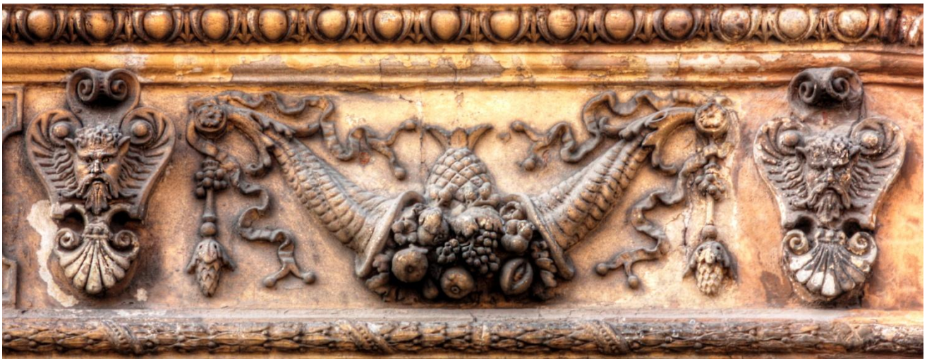
Slika 21. Detalj između prvog i drugog kata u Gajevoj 32. (foto: Antonija Škunca, 19. rujna 2015.)
