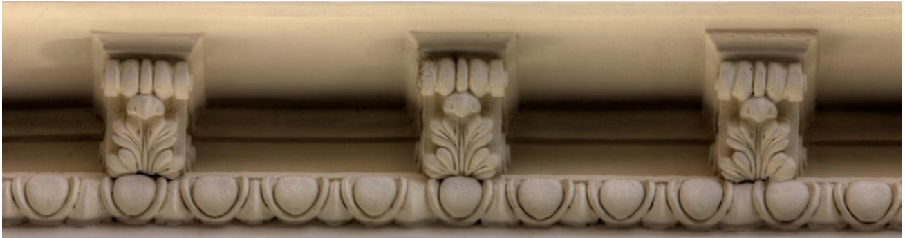
Slika 15. Detalj krovnog vijenca zgrade u Preradovićevoj 13. (foto: Antonija Škunca, 19. rujna 2015.)
