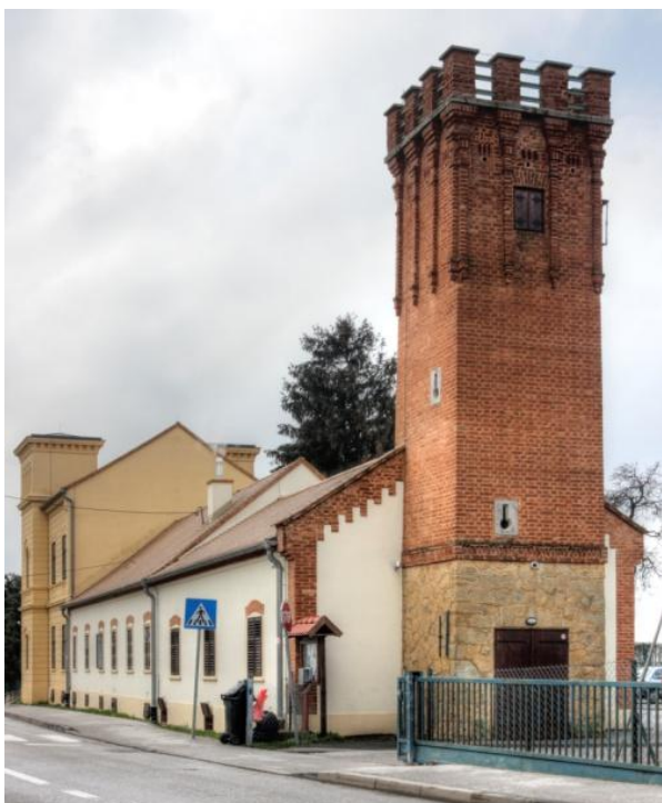
Slika 196. Obnovljen gospodarski dio s kulom u Mikulićima 133. (foto: Antonija Škunca, 16. prosinca 2015.)
