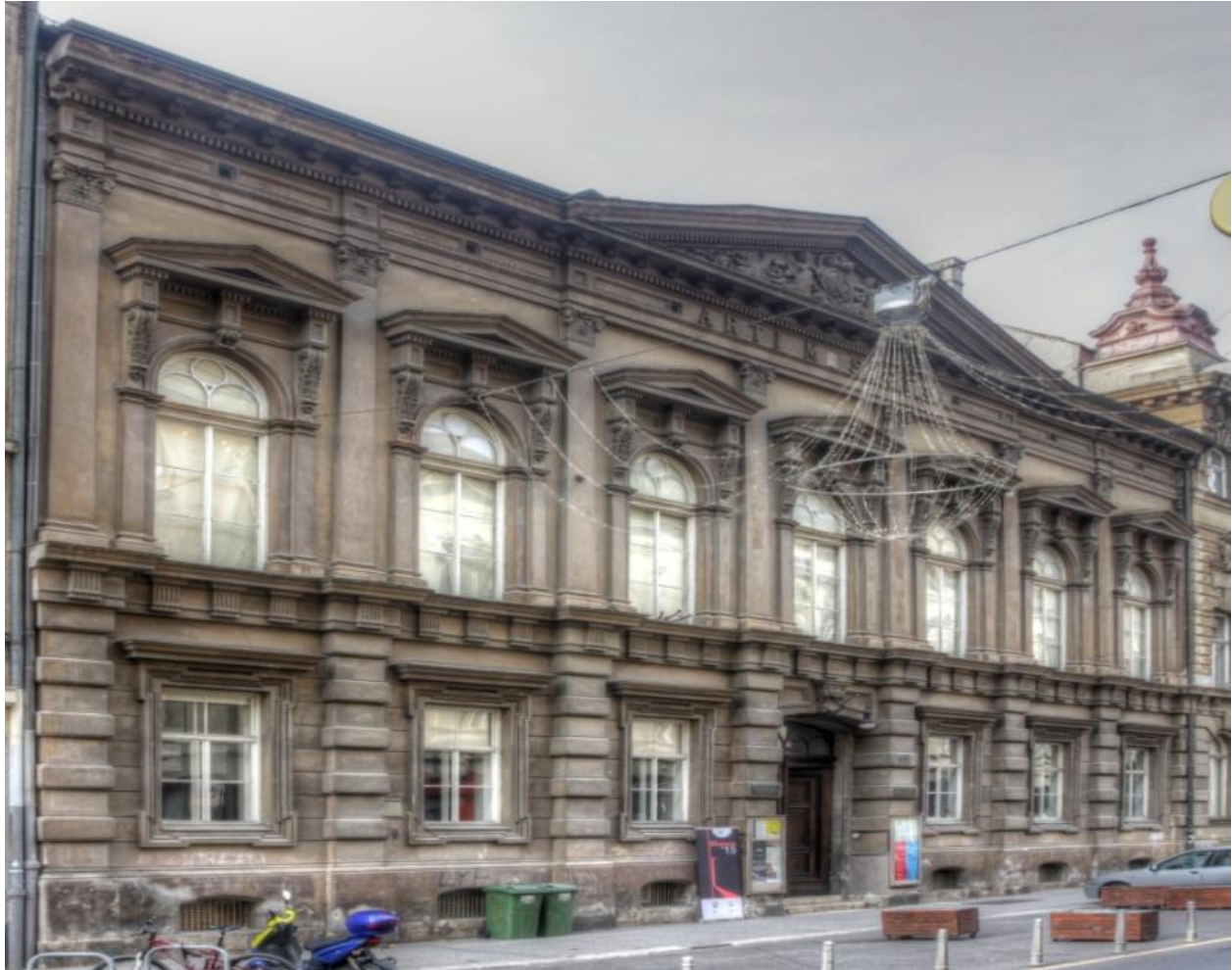
Slika 237. Pročelje zgrade Hrvatskog glazbenog zavoda u Gundulićevoj 6a. (foto: Antonija Škunca, 5. prosinca 2015.)
