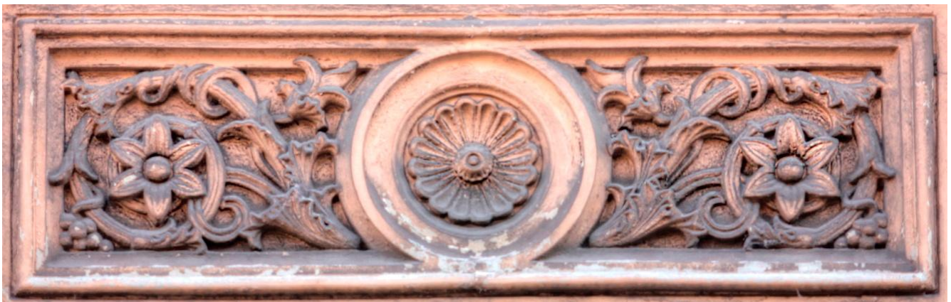
Slika 10. Reljefna ploča ispod prozora prvog kata u Ilici 47. (foto: Antonija Škunca, 30. studenog 2015.)
