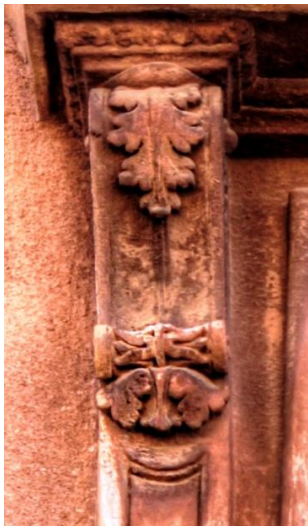
Slika 54. Konzola kraj prozora prvog kata na zgradi u Gajeva 17/Berislavićeva 5. (foto: Antonija Škunca, 12. studenog 2015.)
