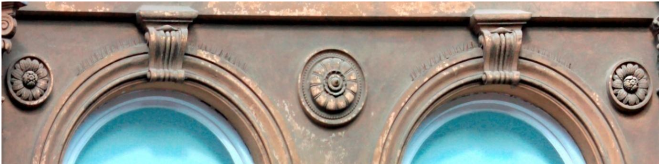
Slika 9. Motiv rozete na zgradi u Ilici 12. (foto: Antonija Škunca, 16. veljače 2016.)
