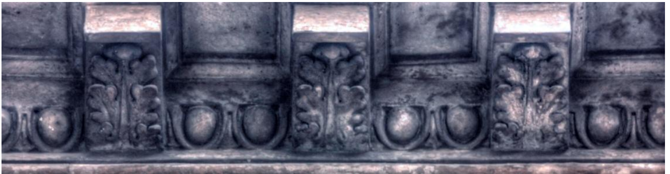
Slika 16. Detalj krovnog vijenca zgrade u Jurišićevoj 23. (foto: Antonija Škunca, 15. studenog 2015.)
