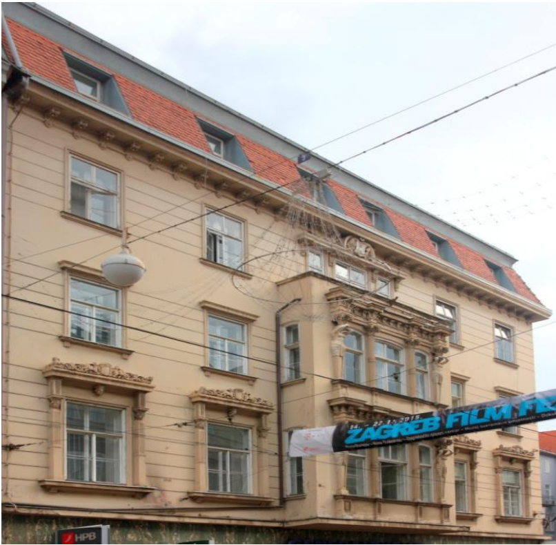
Slika 211. Današnji izgled pročelja zgrade u Praškoj 5. (foto: Antonija Škunca, 2. prosinca 2015.)
