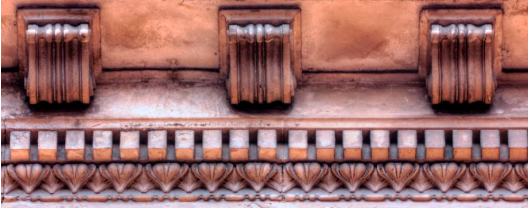
Slika 19. Detalj krovnog vijenca u Ilici 12. (foto: Antonija Škunca, 16. veljače 2016.)
