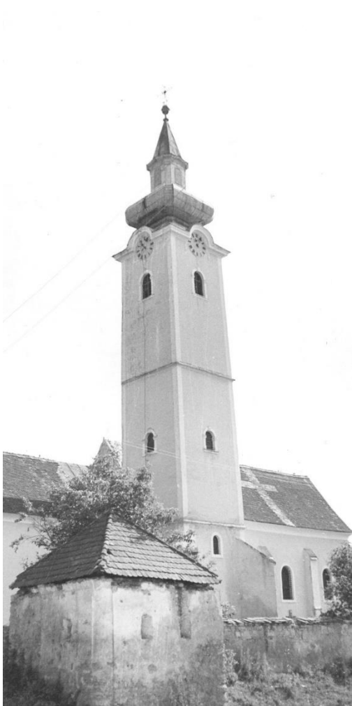
Slika 5 - Zvonik, pogled s jugozapada.
