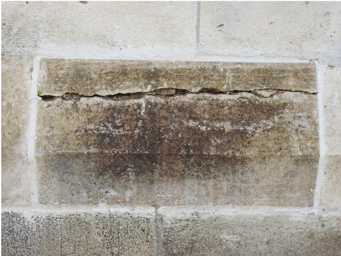
Slika 58 - Oštećenje kamena na sjevernom pročelju, lipanj 2016. godine.
