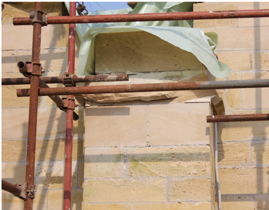
Slika 34 - Oštećenje kamena na kontraforu južnog pročelja, veljača 2011. godine.
