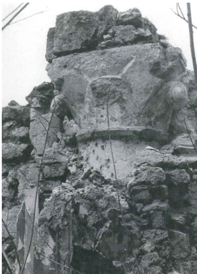
Slika 14. - Unutrašnjost, polustup S2 neposredno nakon uklanjanja kamenog obzida, kolovoz 1995. godine.
