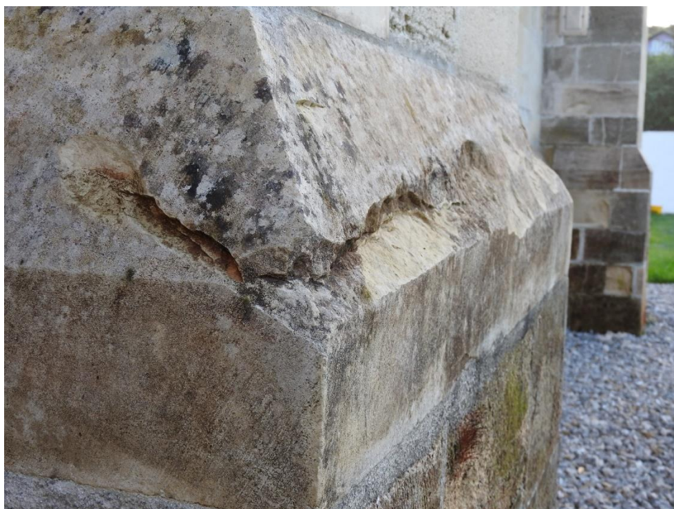
Slika 57 - Oštećenje kamena na kontraforu sjevernog pročelja, lipanj 2016. godine.
