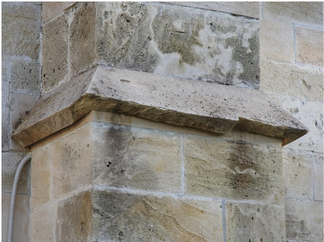
Slika 59 - Oštećenje kamena na kontraforu sjevernog pročelja, lipanj 2016. godine.
