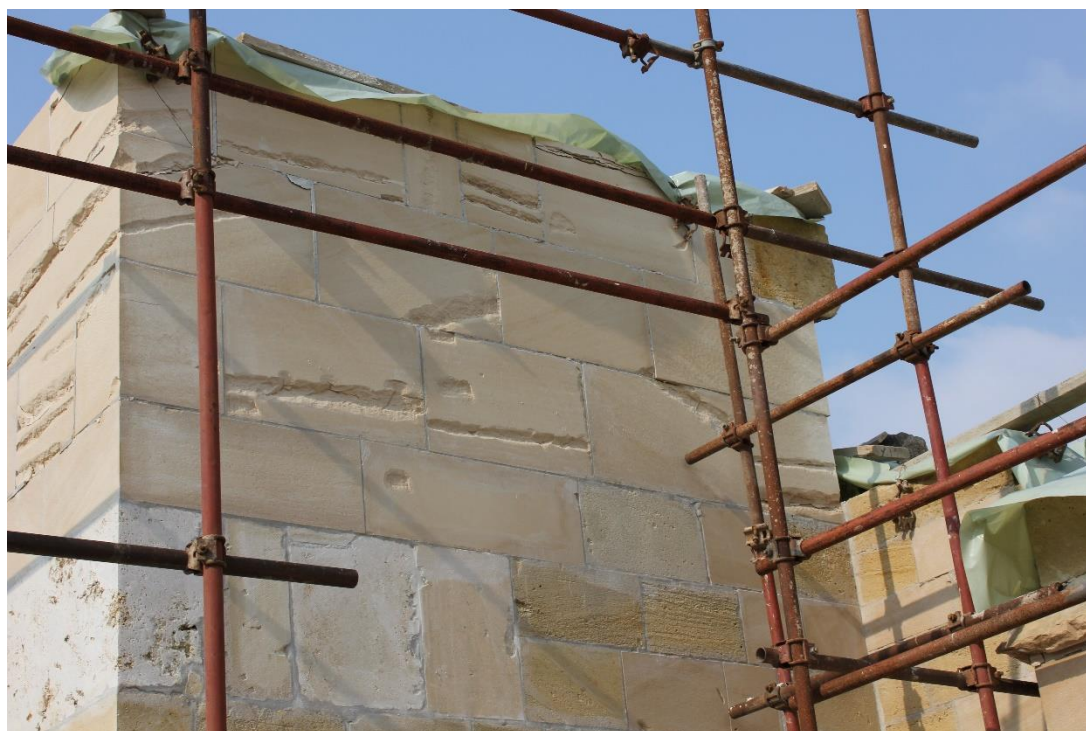
Slika 35 - Oštećenje kamena na zvoniku, veljača 2011. godine.
