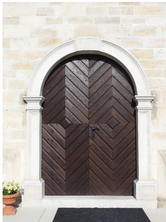
Slika 39 Rekonstrukcija baroknog portala zapadnog pročelja.
