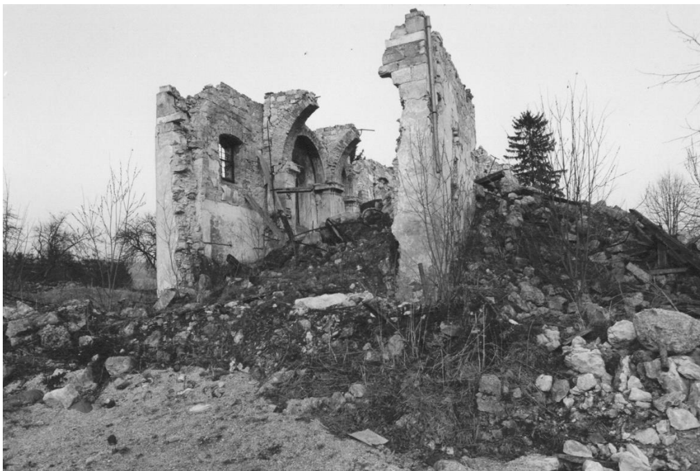
Slika 10 - Crkva u kolovozu 1995. godine, pogled s jugozapad.
