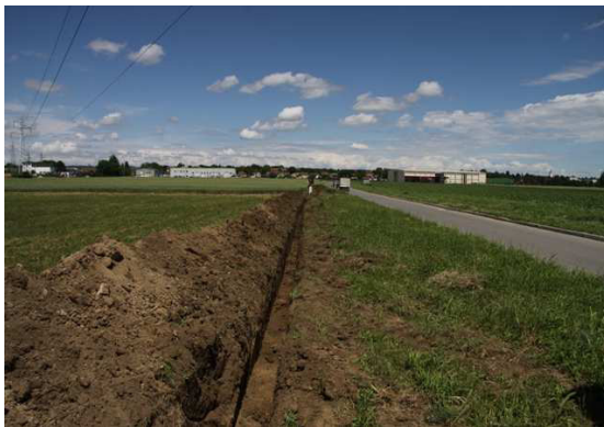
Slika 70. Kneževi Vinogradi ?/2 – rov (2) za distribucijski plinovod (Foto: Vukmanić 2014.). Slika 71. Kneževi Vinogradi ?/2 – pogled na Dragojlov brijeg (Foto: Vukmanić 2014.)
