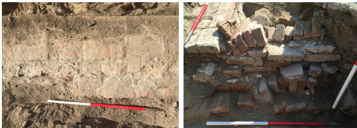
Slika 172. Lug – rimske opeke ugrađene u ogradu Reformirane kršćanske crkve na Gradini (Crkvena 2) (Foto: Cingeli 2015.). Slika 173. Lug – rimske opeke ugrađene u novovjekovni podrum na Gradini (Crkvena 2) (Foto: Cingeli 2015.)
